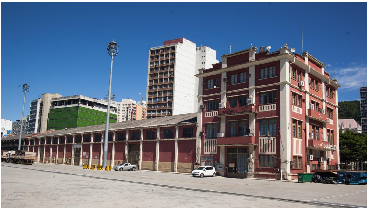
Figura 32 - Vista geral do prédio 5 e Armazém 5.
