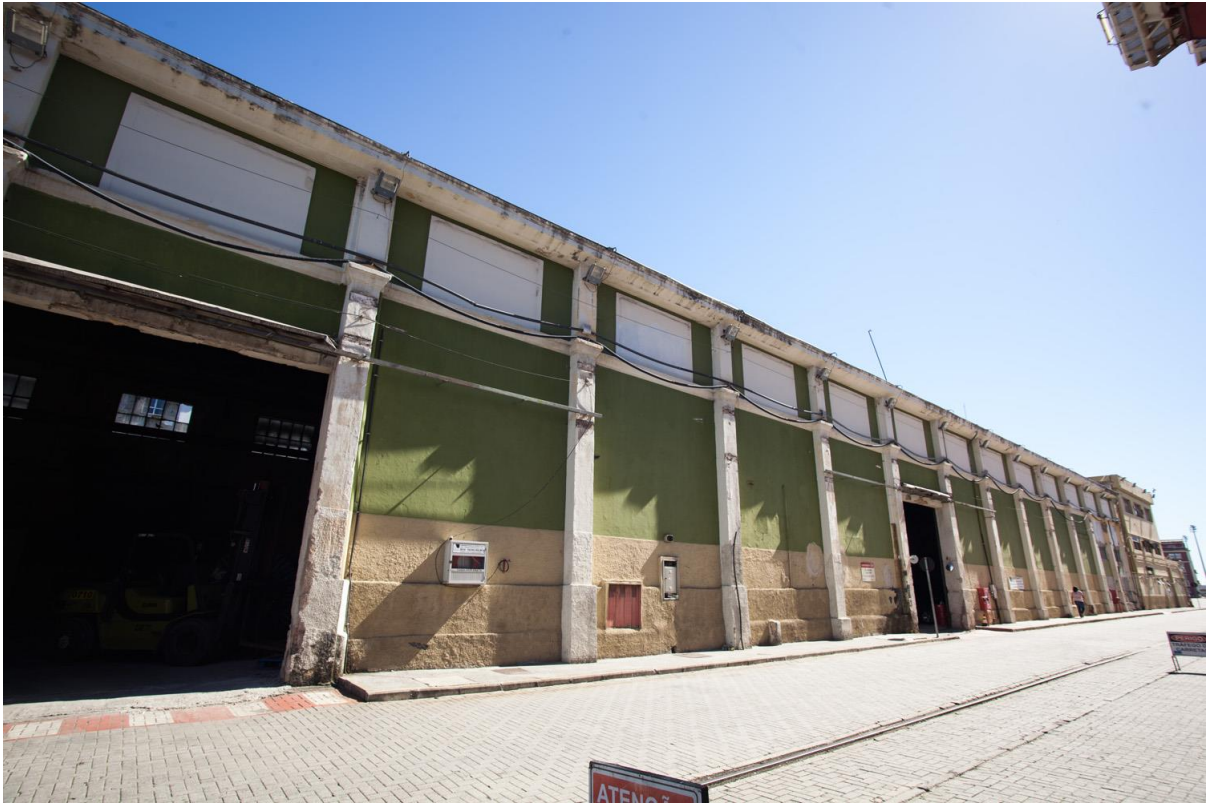
Figura 21 - Vista lateral do Armazém 3.
