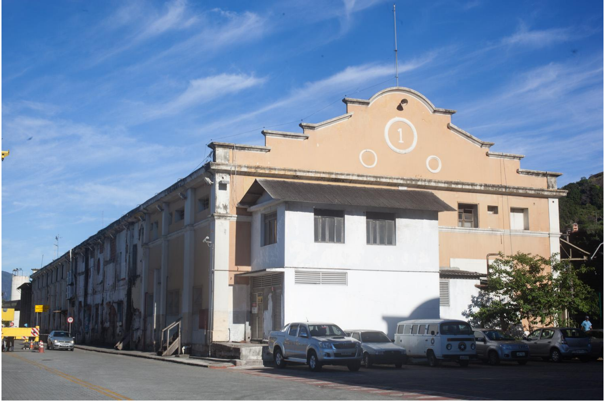
Figura 7 - Vista geral do Armazém 1.
