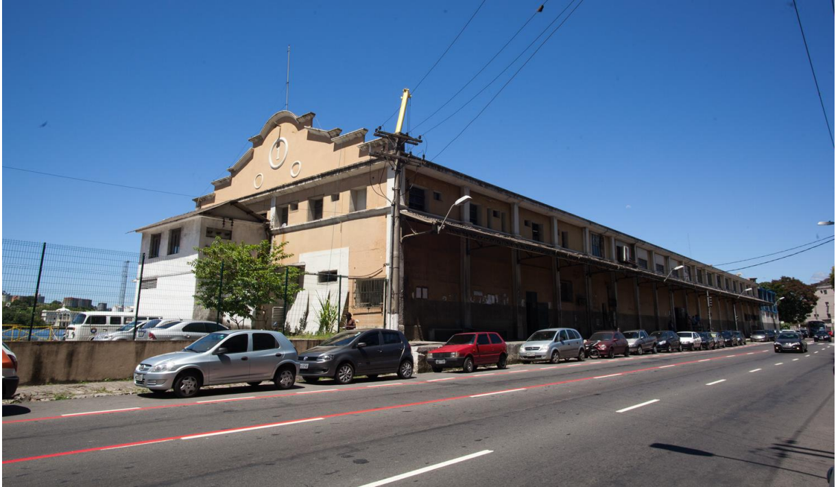
Figura 11 - Vista geral do Armazém 1.
