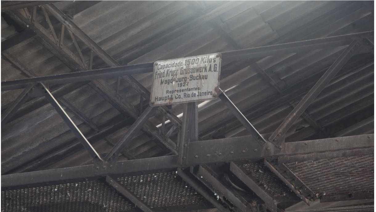
Figura 19 - Placa presente no interior do Armazém 3.
