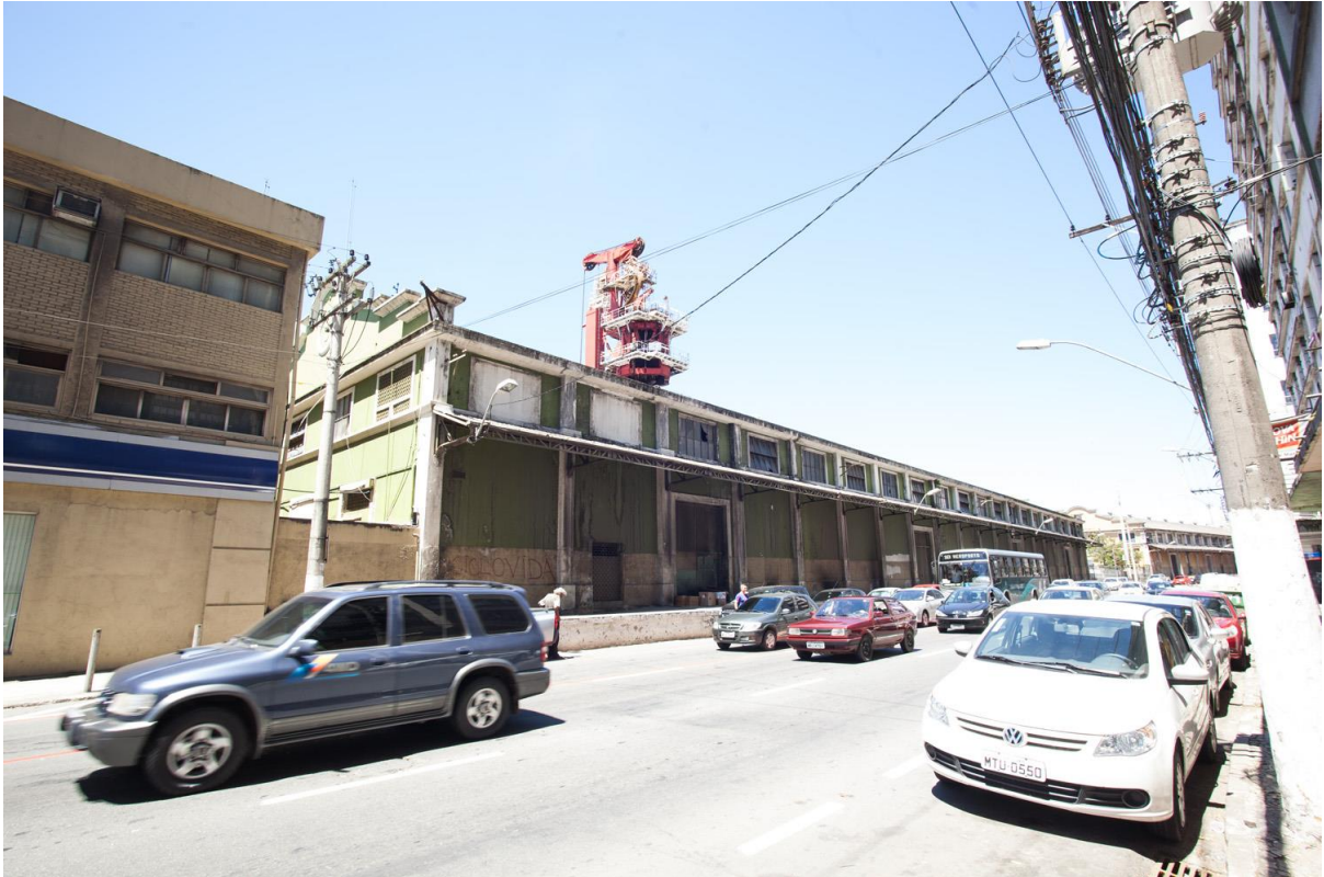
Figura 24 - Vista geral do Armazém 3.
