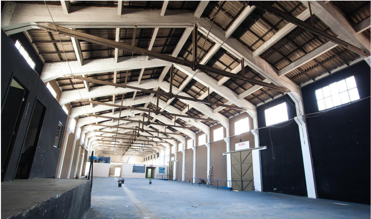
Figura 31 – Vista interna do Armazém 5.
