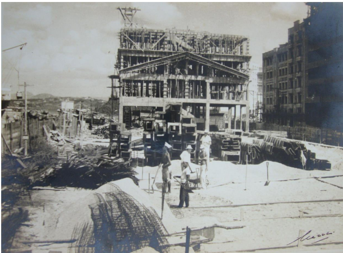
Figura 75 - Alfredo Mazzei. Construção do Prédio 4.
