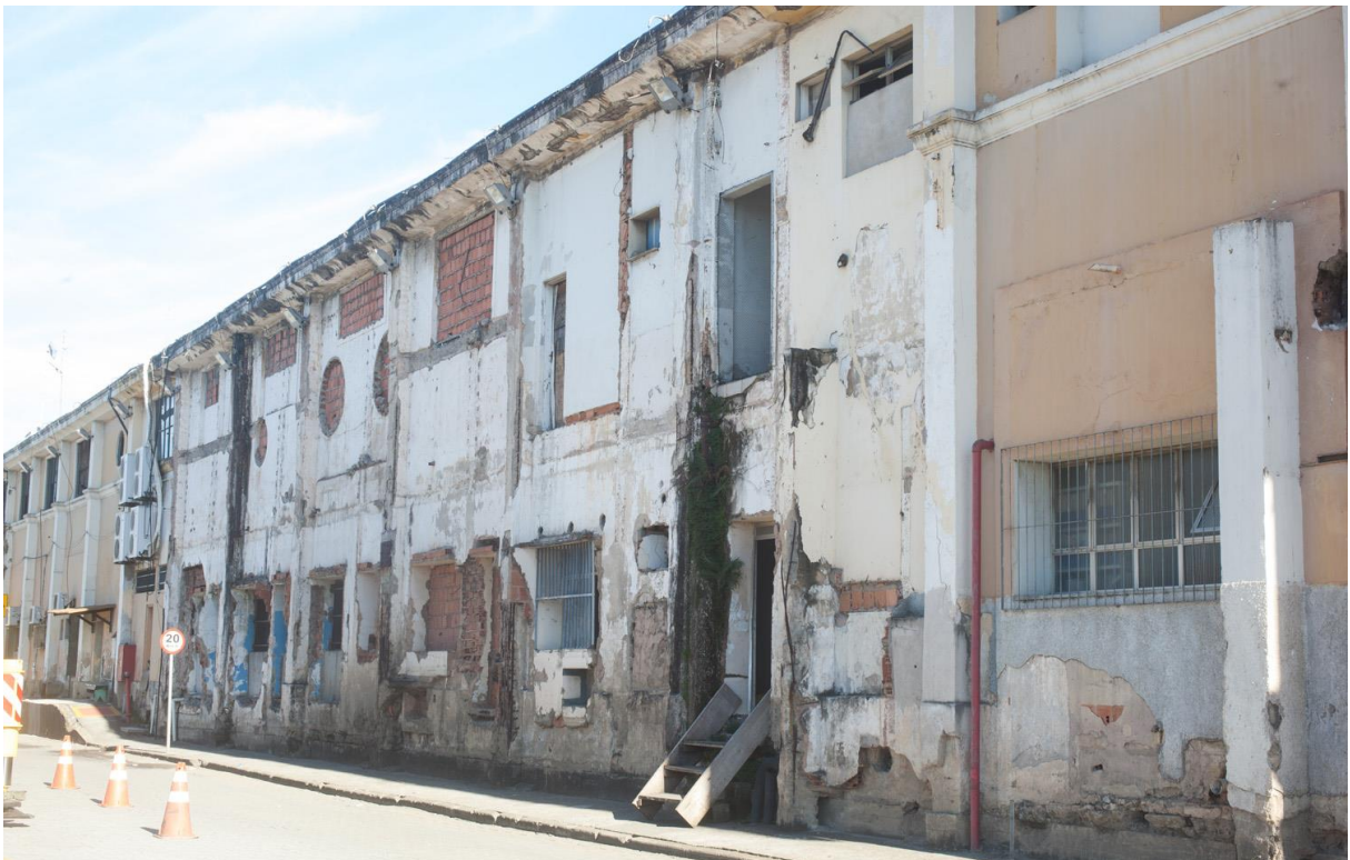
Figura 6 - Vista geral da lateral do Armazém 1.
