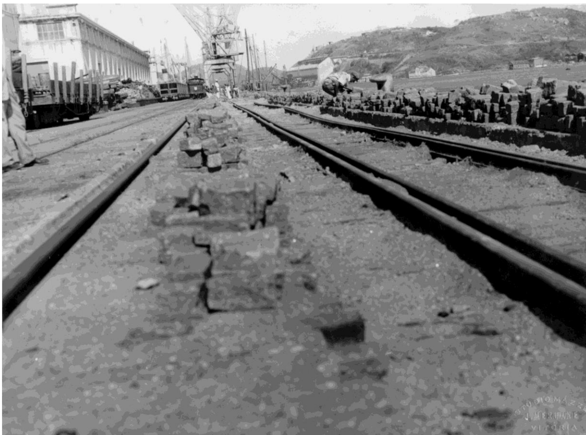
Figura 68 – Studio Mazzei. Vagões e Armazém 3 já concluídos.
