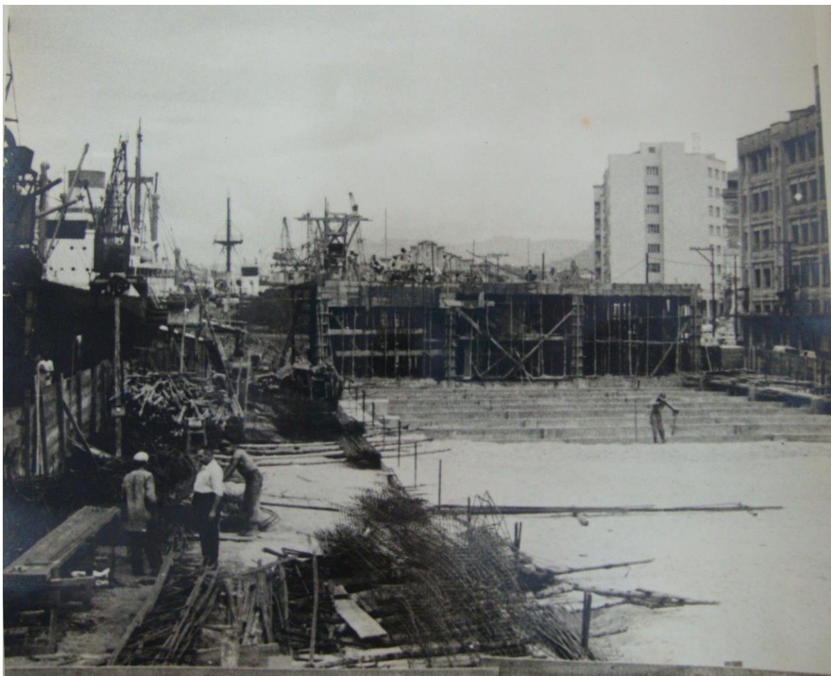
Figura 70 – Alfredo Mazzei. Canteiro de obra (à esquerda) e fundação (à direita) do Armazém 4 (ao fundo Armazém 3).
