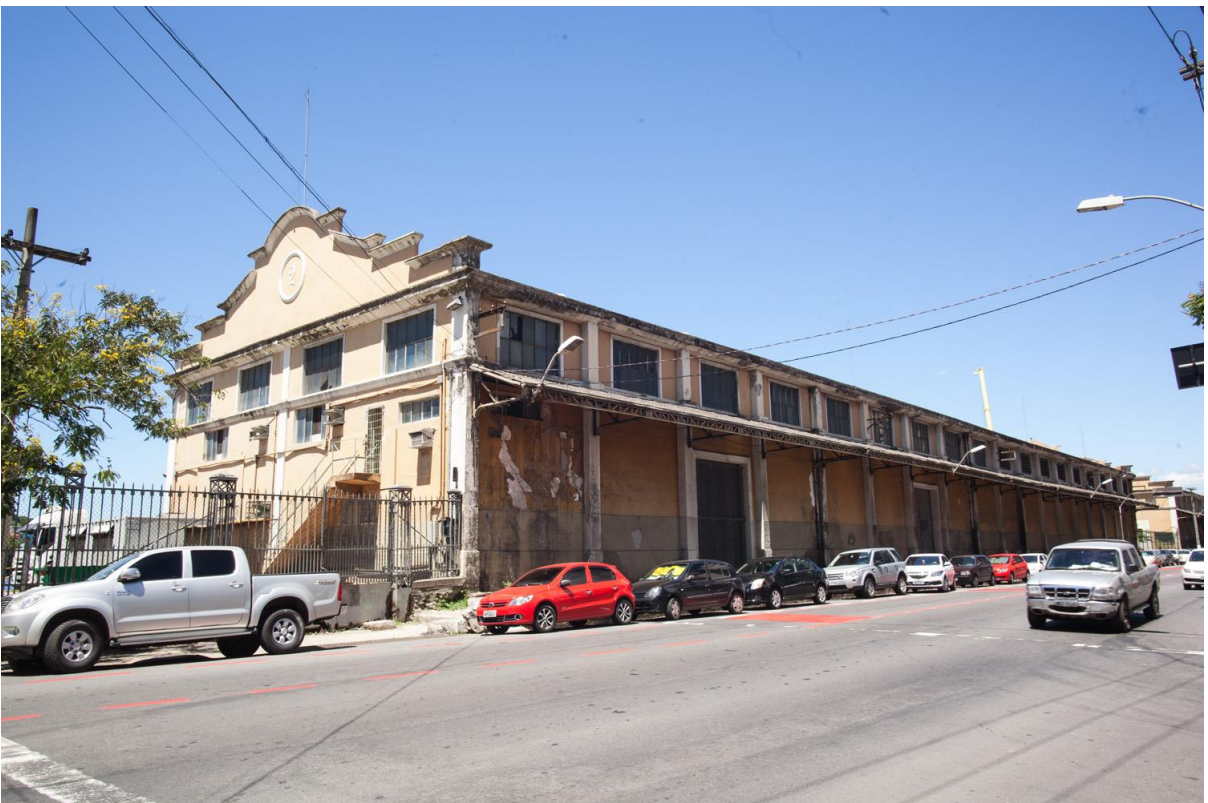
Figura 17 - Vista geral do Armazém 2.
