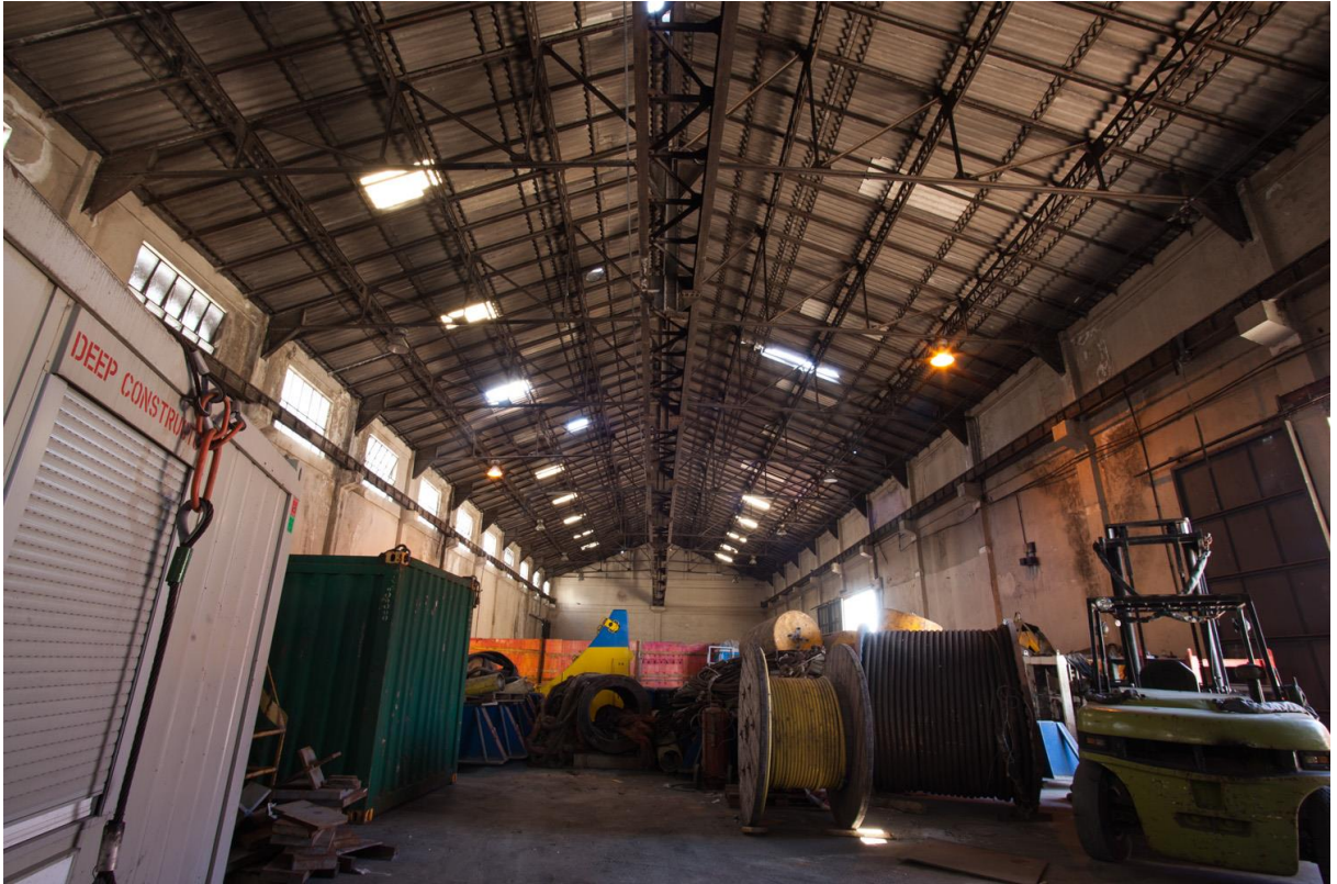
Figura 18 - Vista interna do Armazém 3.
