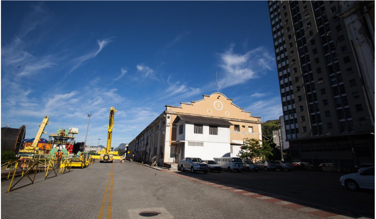
Figura 8 - Vista geral do Armazém 1.
