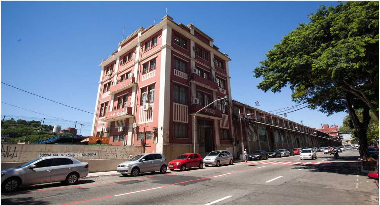
Figura 34 - Vista geral do prédio 5 e Armazém 5.
