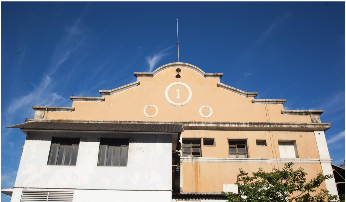
Figura 9 - Detalhe parte frontal do Armazém 1.
