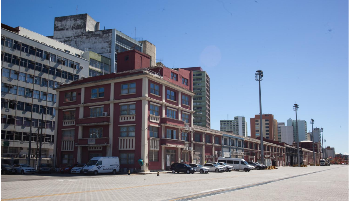
Figura 25 - Vista geral dos armazéns 4 e 5.
