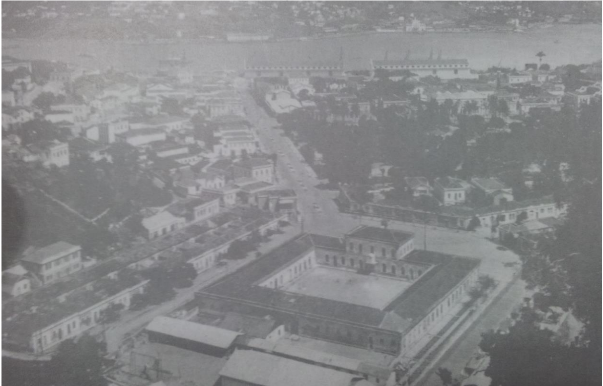
Figura 64 - Quartel da Polícia, 1932. Aspecto com vista para o Parque Moscoso e Bahia de Vitória.
