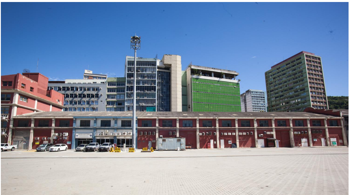
Figura 26 - Vista da fachada do Armazém 4.
