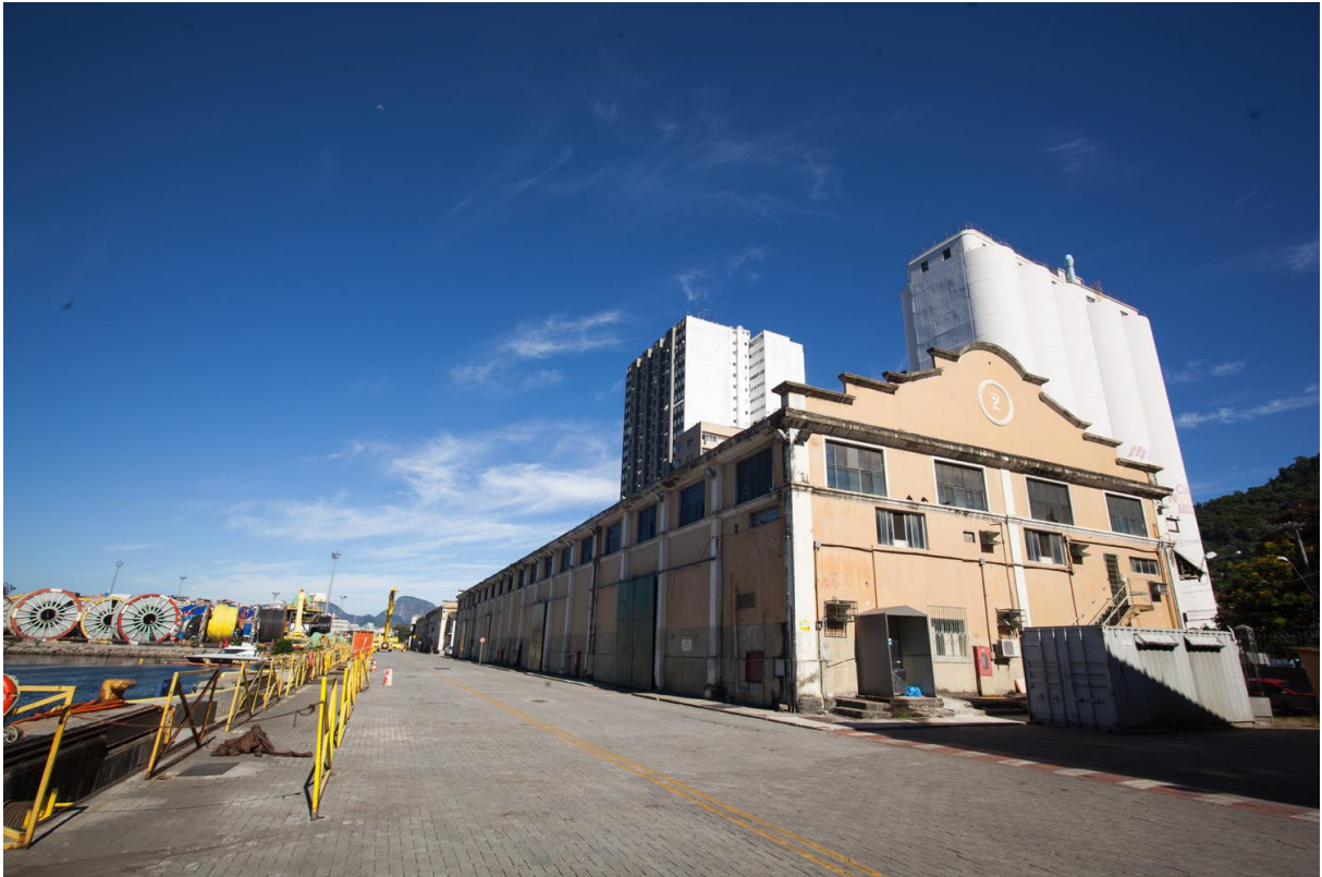
Figura 15 - Vista geral do Armazém 2.
