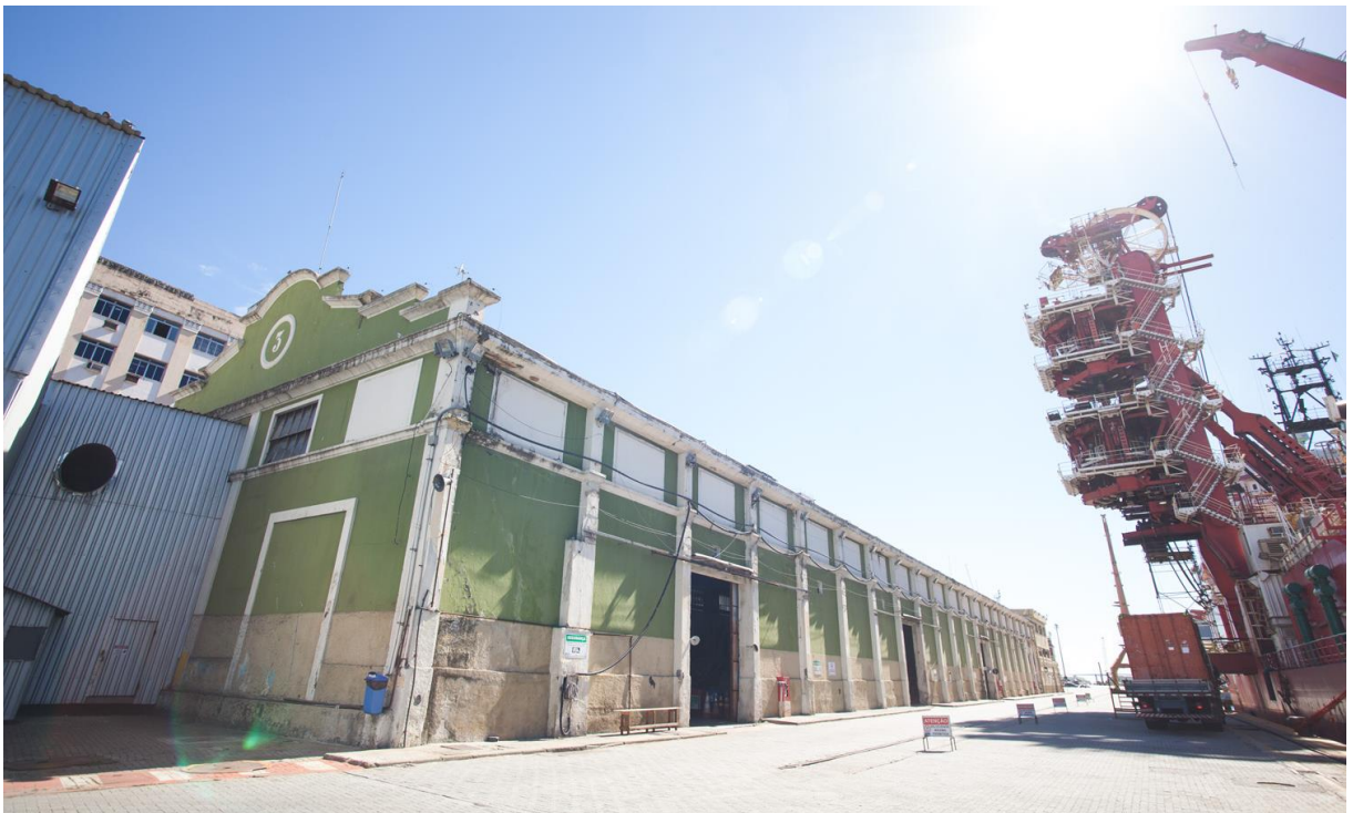
Figura 20 - Vista geral do Armazém 3.
