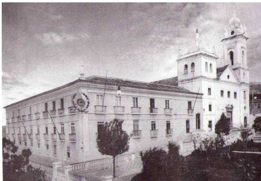
Figura 47 – Trecho da Praça João Clímaco.
