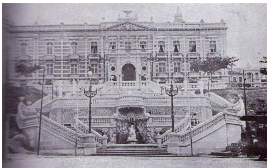
Figura 51 – Palácio do Governo remodelado, com acesso principal orientado para a escadaria frontal reconstruída (1912).
