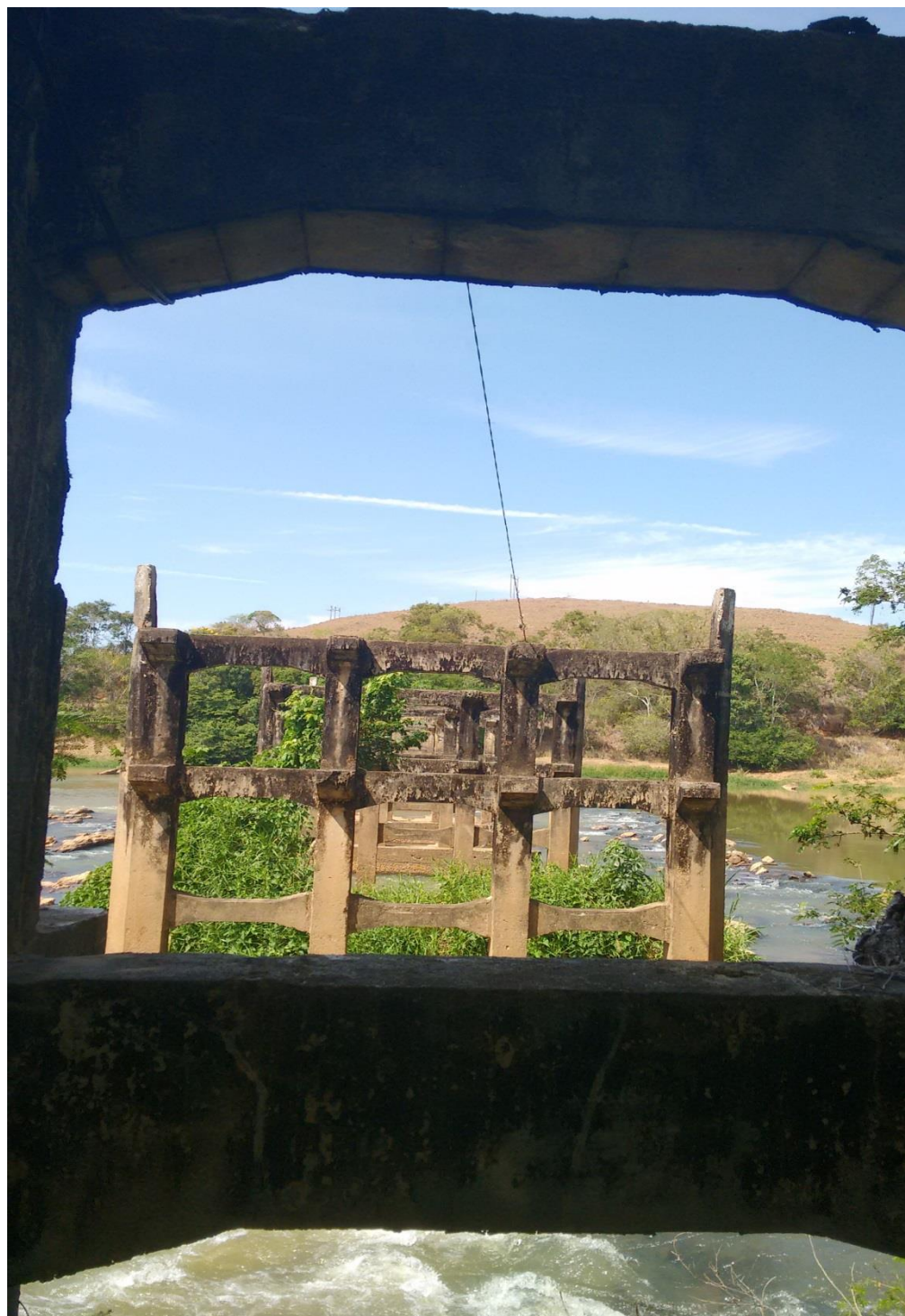
Figura 7 - Ruína da ponte sobre o Rio Itapemirim em Duas Barras Fevereiro de 2015 – Acervo pessoal
