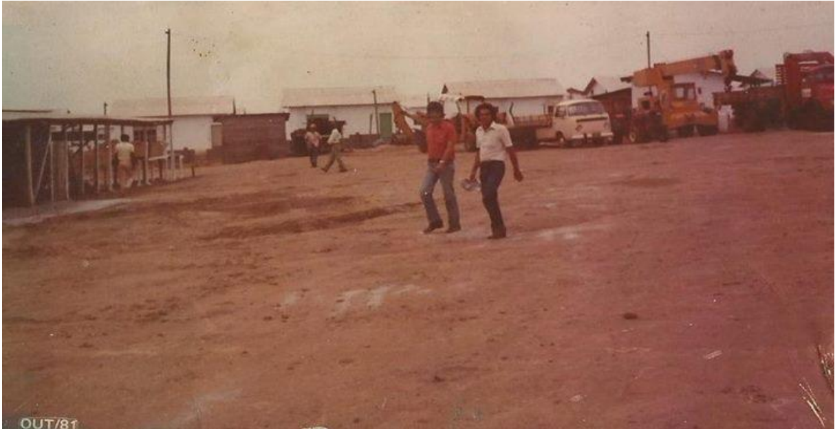
FIGURA 18 – Construção do Conjunto residencial Calabouço, atual bairro Eldorado, Serra, em 1981. Fonte: https://www.facebook.com/photo.php?fbid=695135517195670&set=gm.752151368147286&
