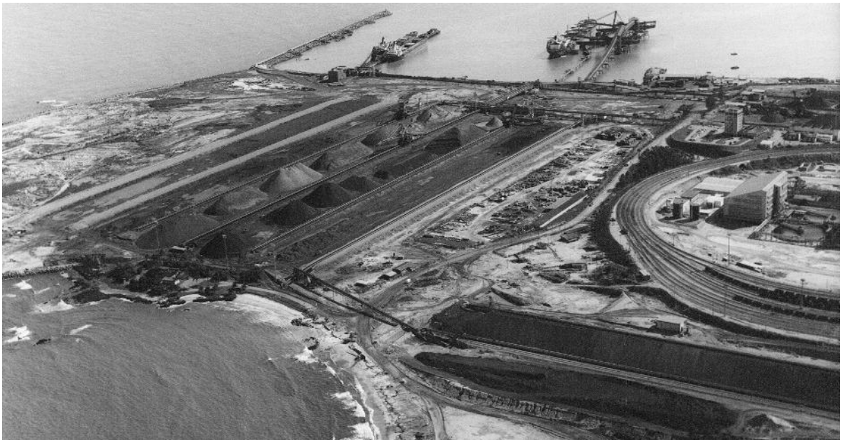
FIGURA 4 – Construção do Porto de Tubarão, no final da década de 1960. Fonte: Vale 15 , 2015
