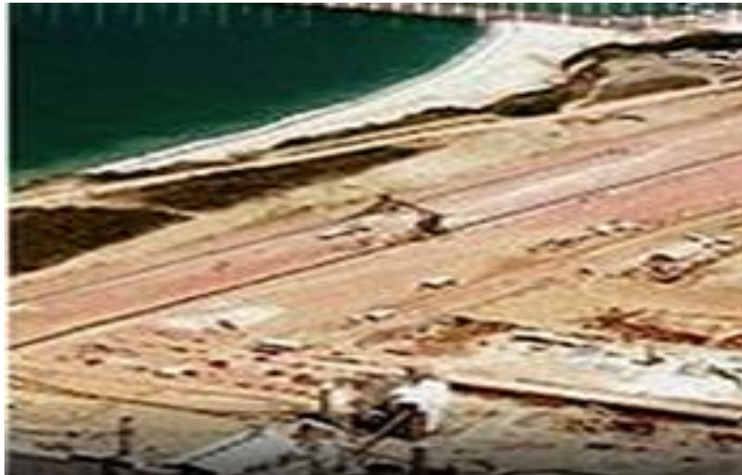
FIGURA 5 – Construção da Samarco Mineração, em 1976. Fonte: Mascarenhas 19 , 2015.
