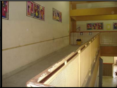
Foto 10 – Rampa interna da Escola Serra
