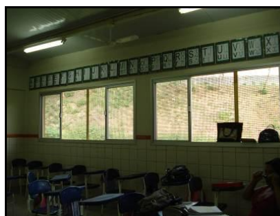
Foto 20 – Janelas da sala de aula da Escola Serra
