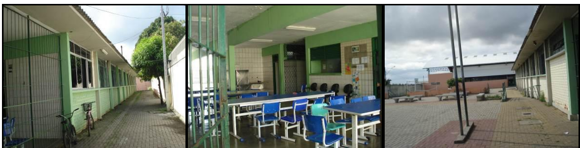
Foto 5 – Pátio aberto e quadra coberta da Escola Carapina, ao fundo
