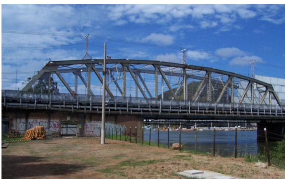
Figura 73 - Cinco Pontes em processo de manutenção. 74
