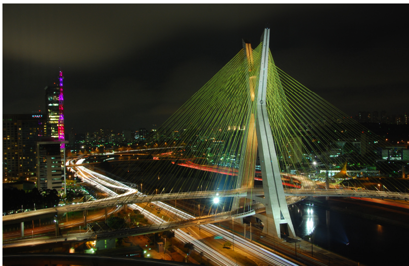
Figura 39 - Ponte Octavio Frias em São Paulo - Brasil. 40
