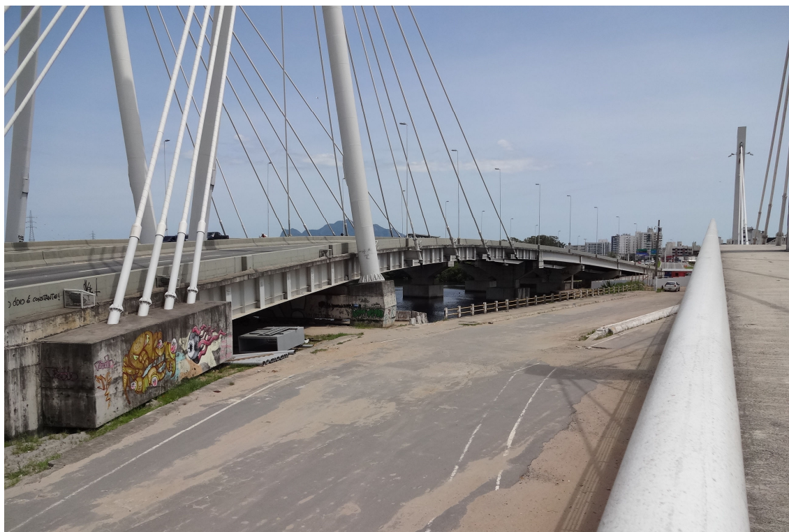
Figura 2 - Pontes da Passagem fotografadas de cima da Passarela Maurício de Oliveira. À esquerda a Ponte Governador Carlos Lindenberg, e ao centro a Ponte Armando Soares de Aguiar. 2
