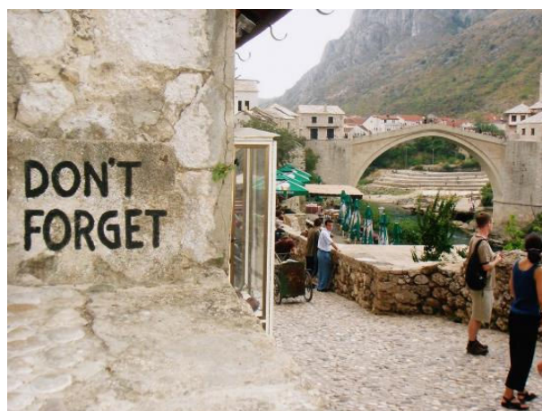
Figura 35 - Ponte de Mostar após reconstrução. 36
