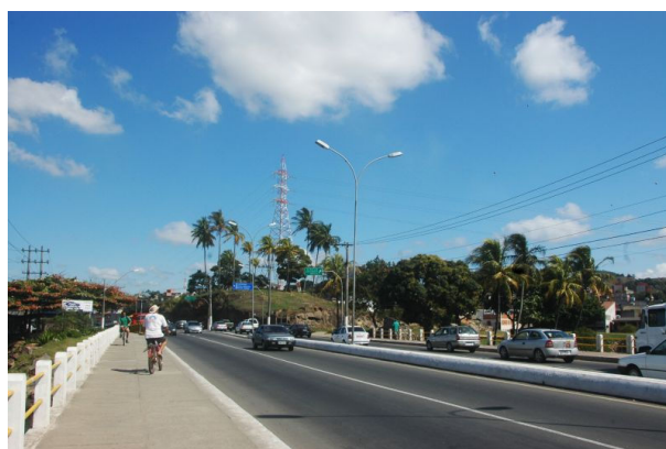
Figura 70 – Ponte Armando Soares de Aguiar, antiga ponte da passagem. 71
