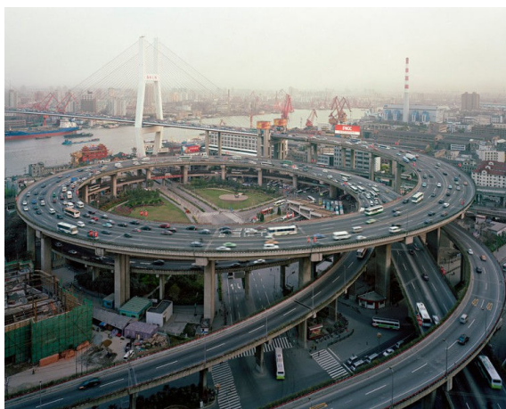
Figura 23 - Nó viário da Ponte de Nantou na China. 24
