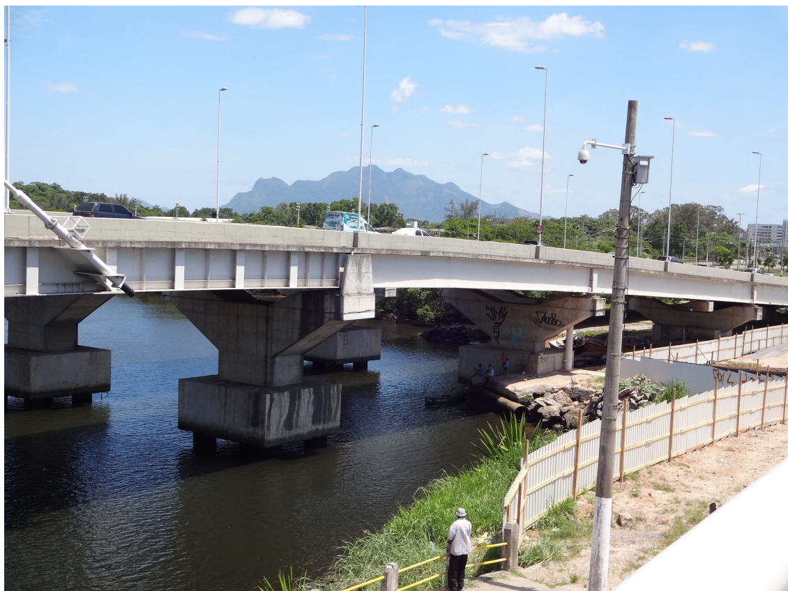
Figura 26 - Vista da Nova Ponte da Passagem. 27 Um homem observa o entorno por sobre a antiga ponte.
