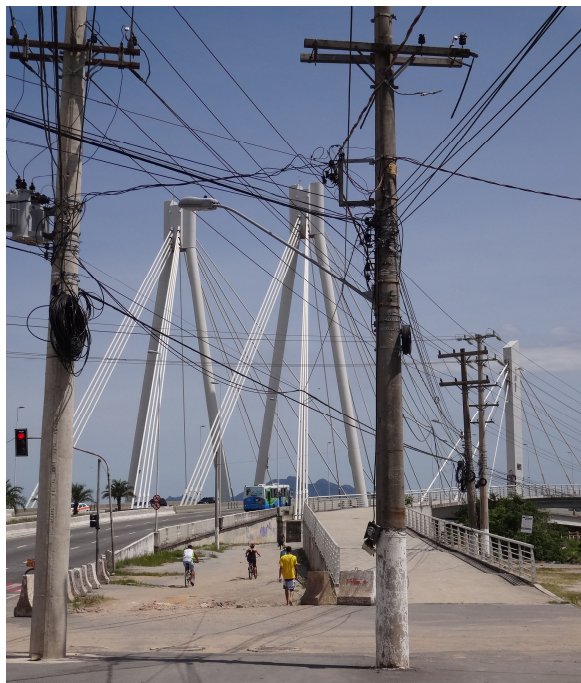
Figura 47 - Pontes da Passagem. Acesso pela Avenida Nossa Senhora da Penha. 48
