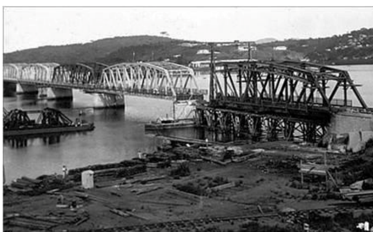
Figura 66 - Ponte Florentino Avidos, ou Cinco Pontes, em construção na década de 1920. 67
