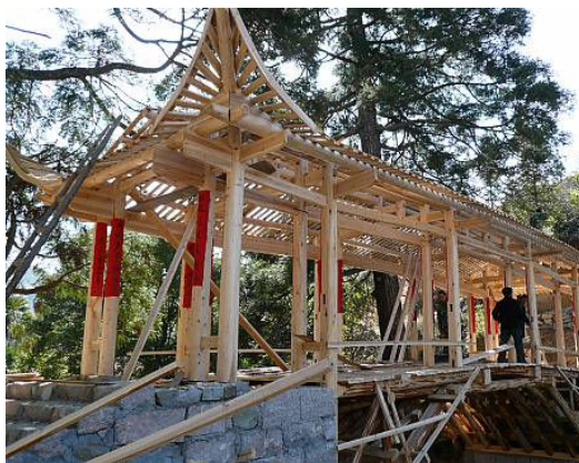
Figura 8 - Construção de ponte tradicional de madeira na China. 8
