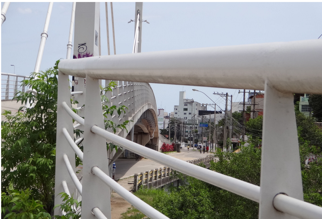
Figura 53 - Vista a partir da passarela de pedestres, em direção à margem norte. 54
