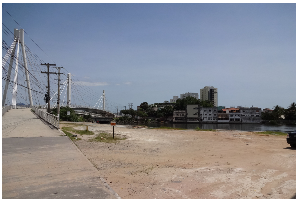
Figura 49 - Vista da cabeceira das Pontes da Passagem e das margens imediatas do canal. 50
