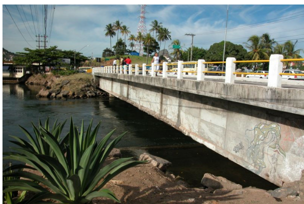
Figura 69 – Ponte Armando Soares de Aguiar, antiga ponte da passagem. 70
