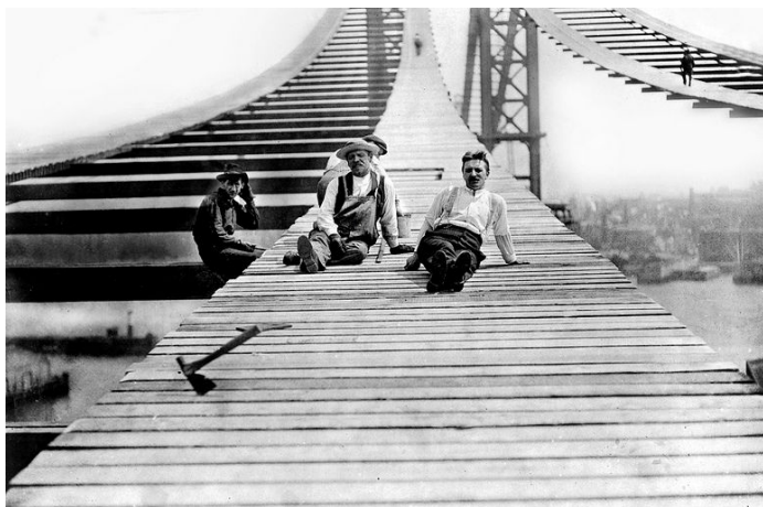
Figura 7 - Construção da Ponte de Manhattan - Nova Iorque (inaugurada em 1909). 7
