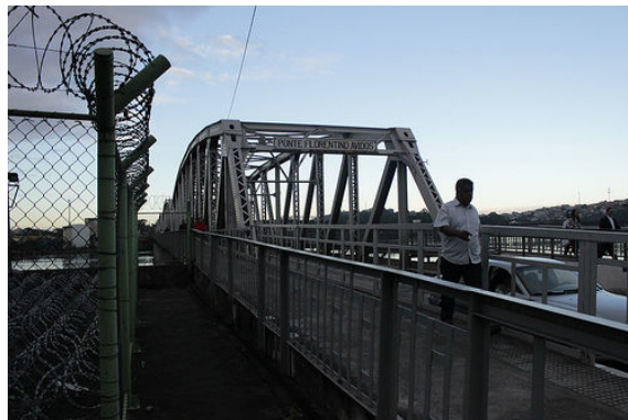
Figura 60 - Faixa destinada aos pedestres na Ponte Florentino Avidos. 60
