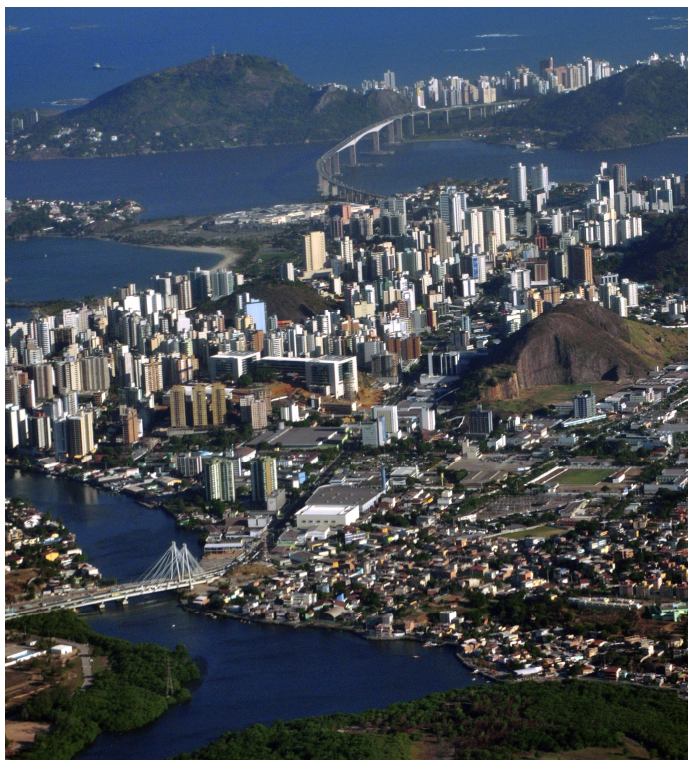
Figura 58 - Vista da Ponte da Passagem (abaixo), que conecta a ilha à porção continental de Vitória. Com a construção da Passarela Maurício de Oliveira, tornou-se possível nesse trecho a travessia por pedestres, ciclistas, e veículos motorizados. Acima, vista da Ponte Deputado Darcy Castello de Mendonça, ou Terceira Ponte, conectando Vitória a Vila Velha, e onde a travessia é possível apenas por veículos motorizados. 58
