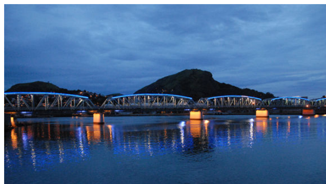
Figura 74 - As Cinco Pontes com iluminação de destaque, atualmente danificada. 75
