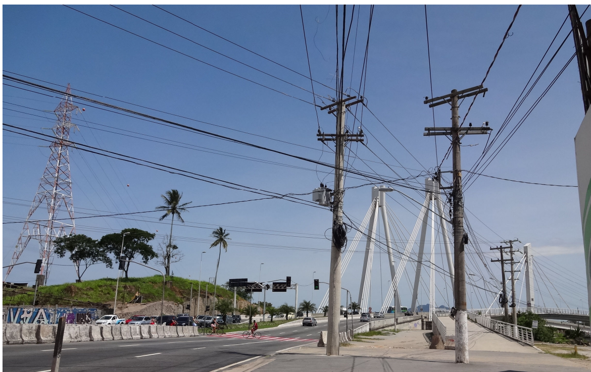
Figura 3 - Vista do acesso às Pontes da Passagem na Avenida Nossa Senhora da Penha. 3
