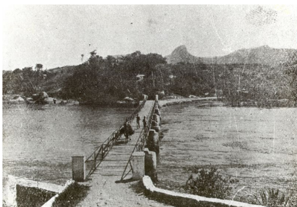
Figura 67 - Pinguela da Passagem, na década de 1920. 68
