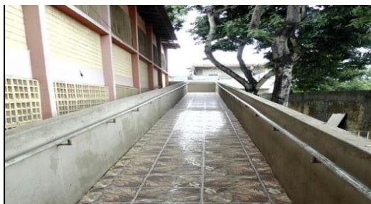
Figura 2 - Visão lateral do prédio anexo.
