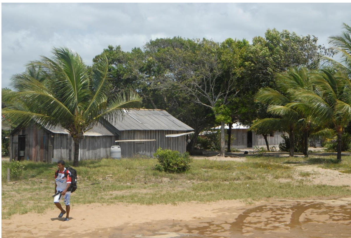
Figura 10 – Detalhe de um tipo de residência da comunidade do Bugigão. Todas as residências são feitas de madeira com telhado de amianto, uma das condicionantes impostas pelo Parque Nacional do Monte Pascoal era que as casas fossem de madeira, e não de alvenaria. Fotografia de Jerônimo Amaral de Carvalho – outubro de 2013.
