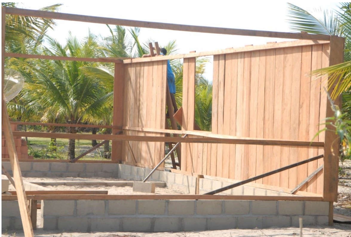
Figura 15 – Futura casa de Caboclo (acredito que já esteja morando nela), sendo feita em madeira, mas assim como demais, construída com uma base e colunas em alvenaria se preparando para algum dia sair a resolução sobre a ocupação no Parque Nacional do Monte Pascoal. Fotografia de Jerônimo Amaral de Carvalho – outubro de 2013.
