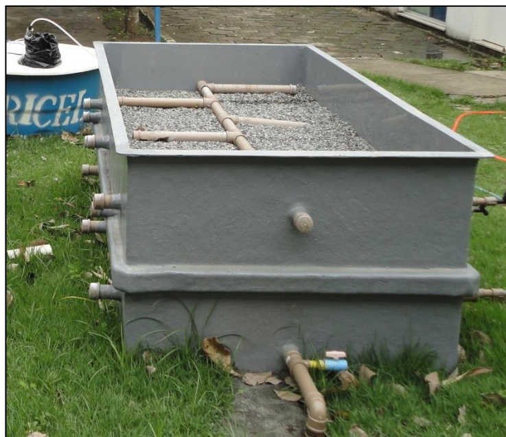
Figura 21 – “Wetland” vertical antes do plantio da macrófita, com a tubulação em forma de “espinha de peixe”
