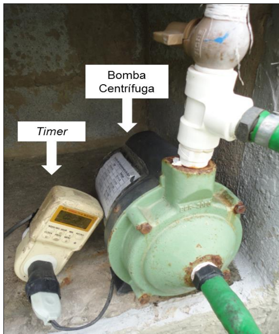
Figura 5 – Bomba centrífuga associada ao timer
