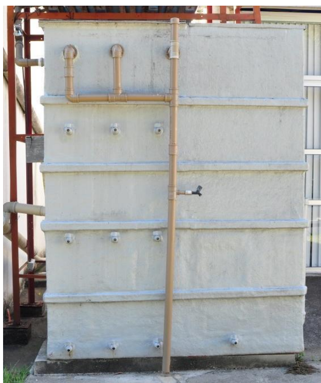
Figura 6 – Filtro anaeróbio de fluxo ascendente
