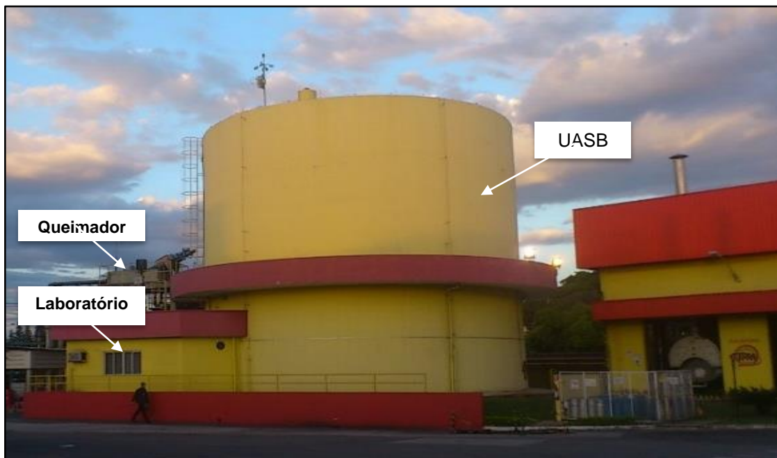
Figura 10 - Vista do Reator UASB na Fábrica de Chocolate
