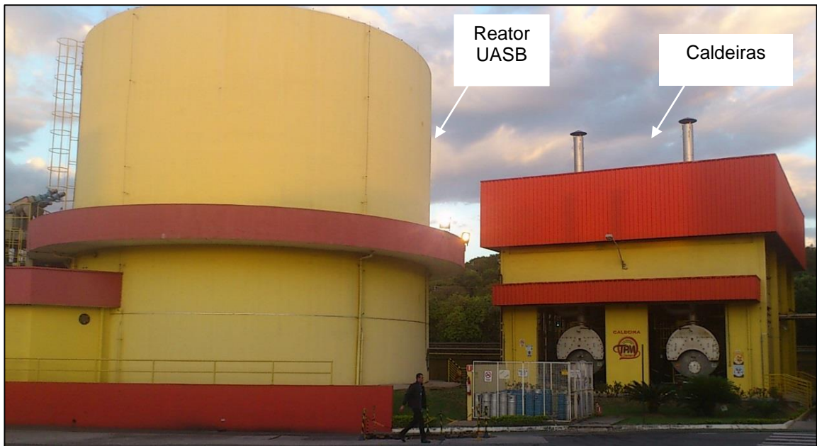
Figura 21 - Vista do Reator UASB e as caldeiras da fábrica em estudo.
