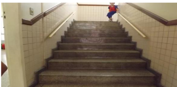
Escada de acesso ao segundo andar
