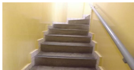
Escada de acesso à sala da direção
