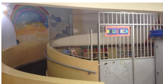
Rampa de acesso ao 3º andar e Biblioteca
