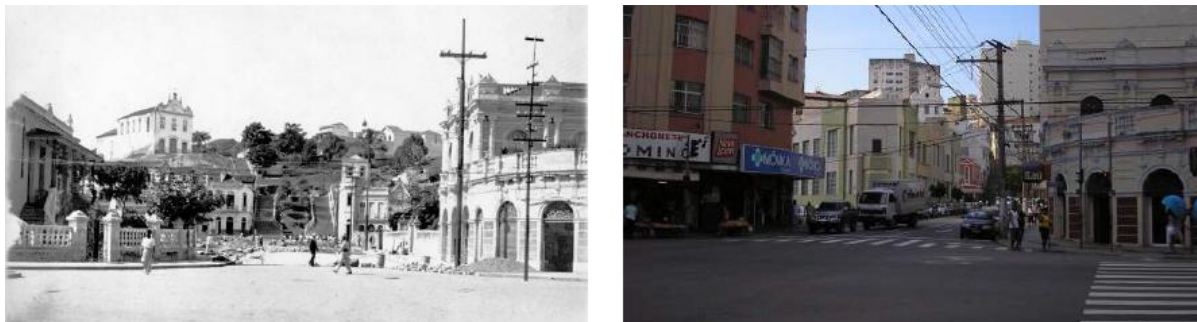
Figuras 31 e 32: À esquerda visual da igreja São Gonçalo a partir da esquina das avenidas Cleto Nunes e República, no início do século XX e à direita, a partir da mesma visada, no ano 2006, observa-se a perda de destaque da edificação.
