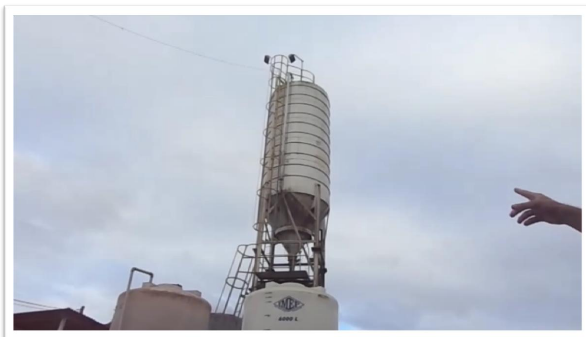
20(b) Misturador de concreto.
