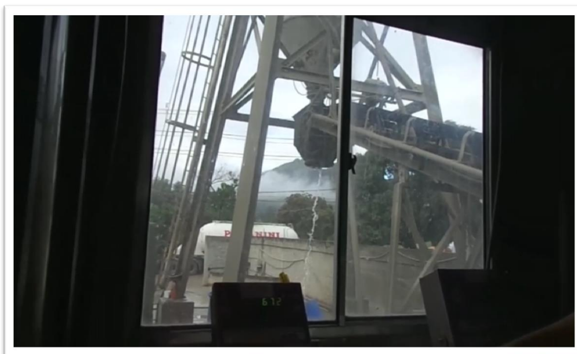
20(d) Preparo da massa de Concreto.
