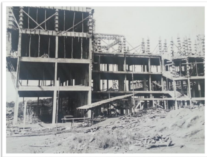
Figura 15: Construção do Prédio do CSCM nos anos 50 – Construção do Prédio 1954.
