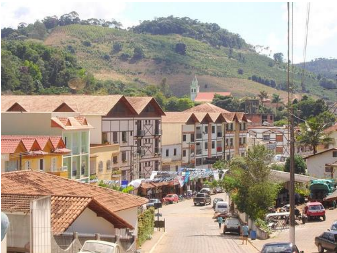
Figura 5 – Estilo arquitetônico de algumas construções de Santa Maria de Jetibá.
