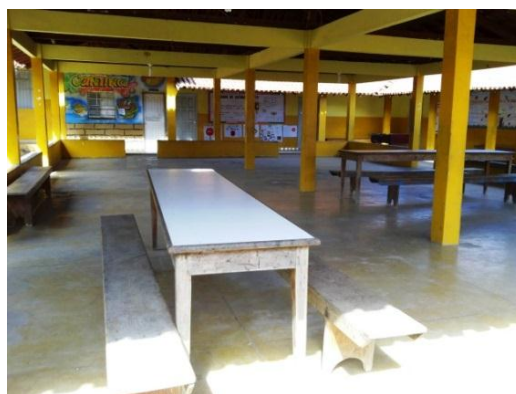
Imagem 20: Pátio / Refeitório Escola C
