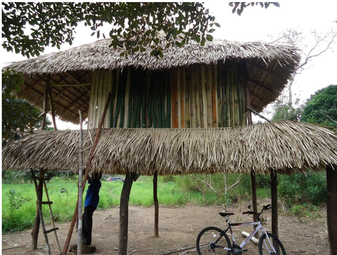
Figura 11: Índio guarani construindo sua casa.
