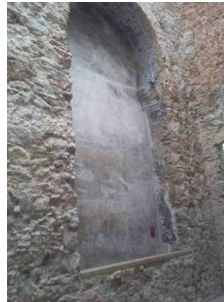
Figura 59 - Arco encontrado sob as sucessivas reformas feitas ao longo dos séculos. O arco encontra-se na mesma parede de acesso às galerias.
