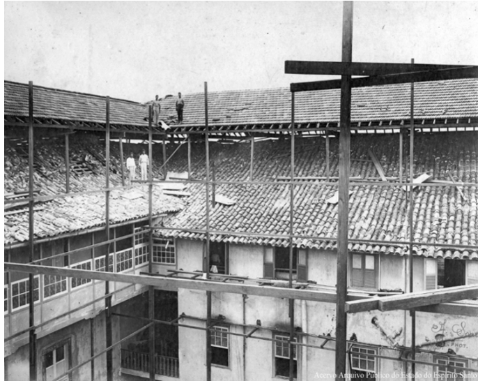
Figura 48 – Foto interna do Palácio Anchieta, mostrando as reformas preliminares no e o levantamento do telhado original
