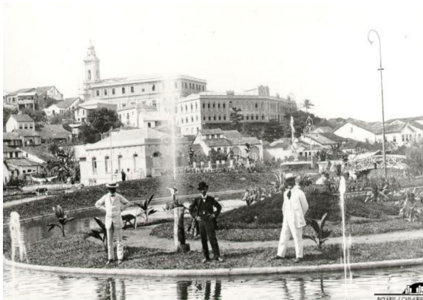
Figura 88 – Foto, de 1912, da área do Campinho transformada no Parque Moscoso, tendo ao fundo, e no alto, o prédio de São Tiago, antes das reformas de 1908-12. Foto do acervo da Biblioteca Central/Centro de Artes da Universidade Federal do Espírito Santo. Fonte: MIRANDA, 2014
