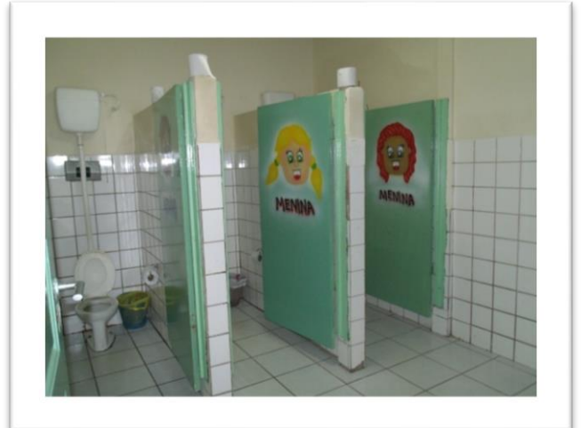
Foto 13 – Banheiros da escola
