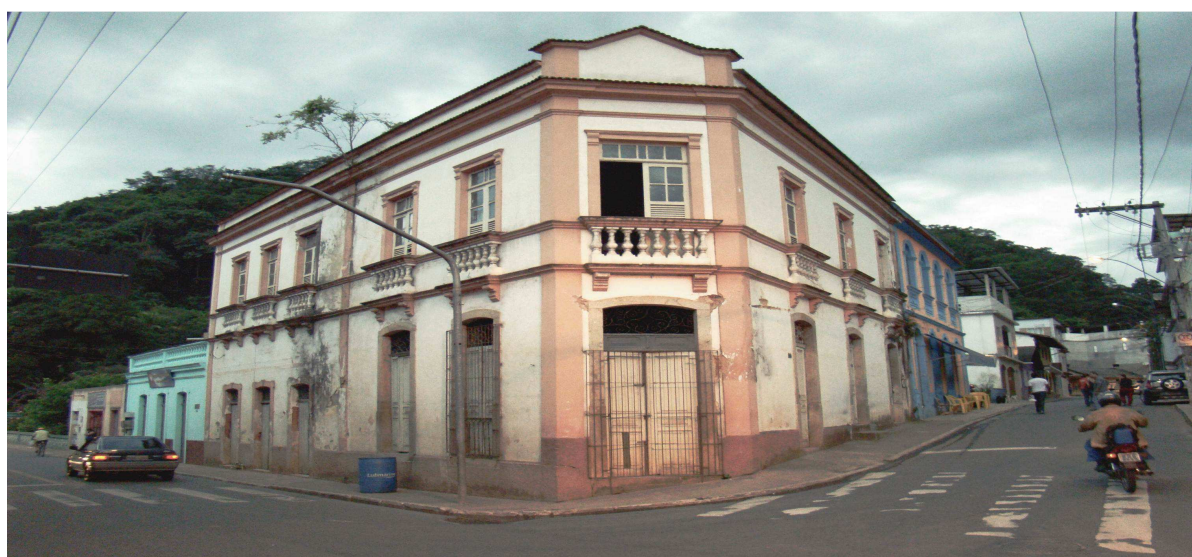
Figura 13: Imóvel de propriedade da Prefeitura Municipal de Santa Leopoldina, em mau estado de conservação e sem uso (05/2014)
