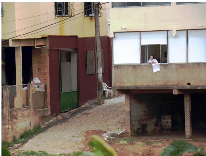
Figura 7: Detalhe do atual estado ao qual se encontram os fundos de imóveis tombados localizados na Rua Principal do sítio histórico de Santa Leopoldina (05/ 2014)
