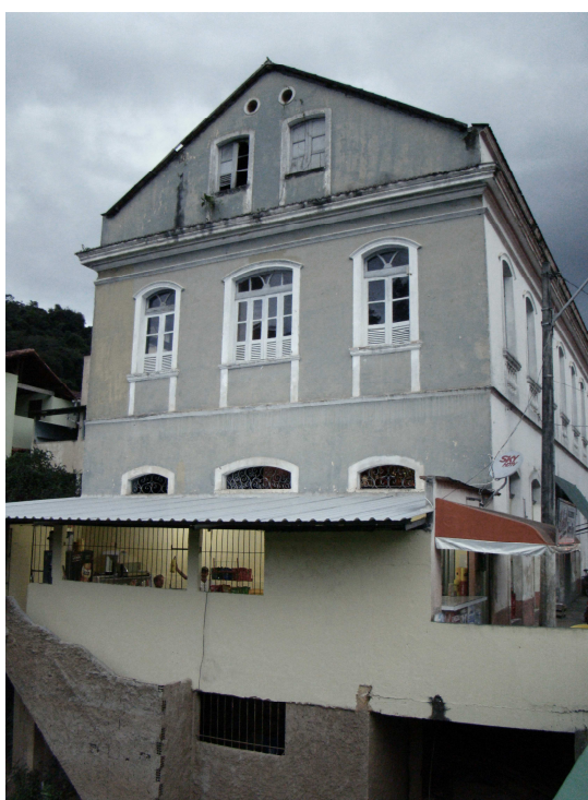
Figura 8: Descaracterização dos fundos do imóvel tombado e precário estado de conservação (05/2014)
