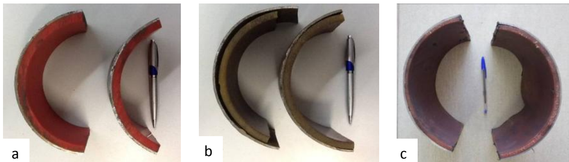
Figura 27: Vista transversal de seções de tubulações de polpa de minério onde foram extraídos a) Pu1, b) Pu2, c) Pu3.
