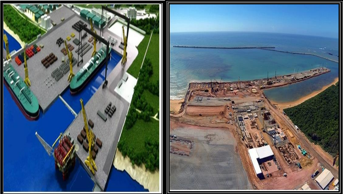
Figuras 30 e 31. Maquete do estaleiro e a sua construção no município de Aracruz.
