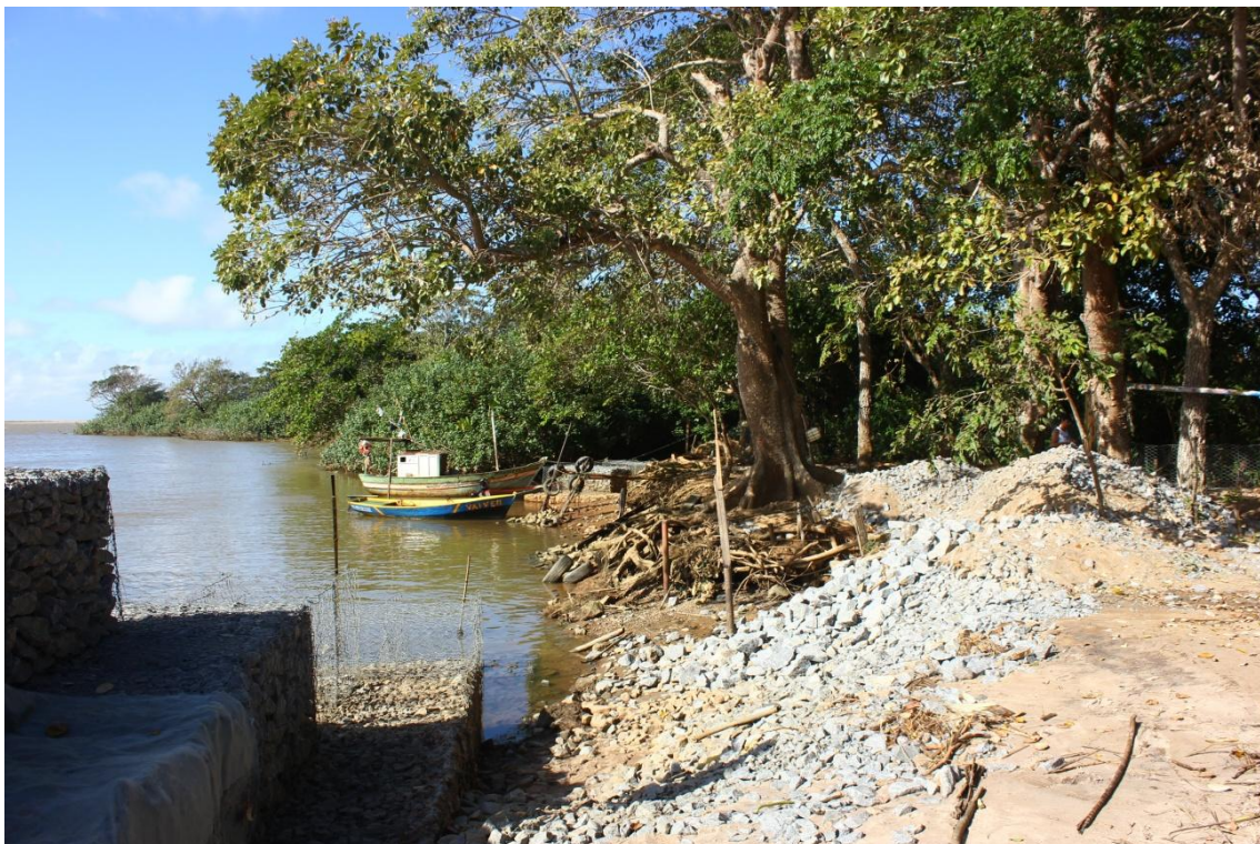
Fotografia 5: Porto dos pescadores localizado no rio Doce (em reforma).
