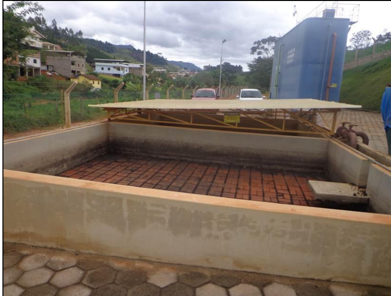
Figura 5 – Vista dos leitos de secagem na ETE Piaçu antes da montagem do experimento.
