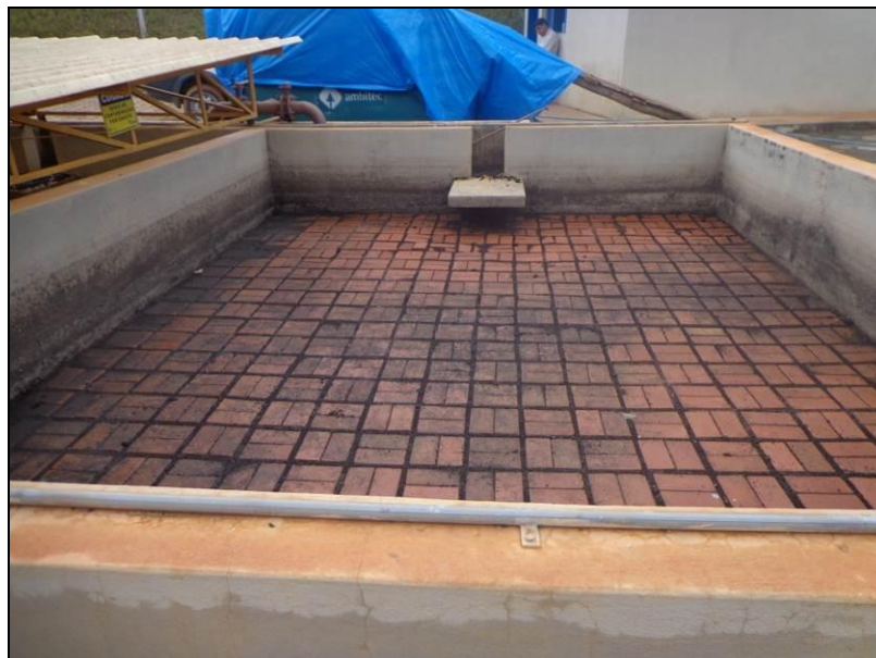
Figura 6 – Vista do leito de secagem (Leito 2) na ETE Piaçu.
