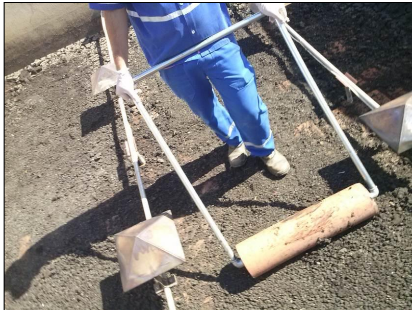
Figura 14 - Compressão do lodo seco, com o rolo compressor utilizado na pesquisa, para quebrar os torrões.
