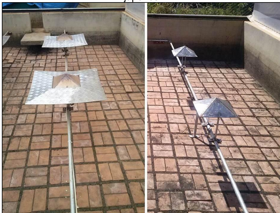
Figura 2 – Ampliação das dimensões laterais de cada chapéu japonês.
