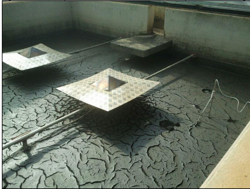
Figura 17 – Aspecto do Leito 2 no 4º dia após a descarga.
