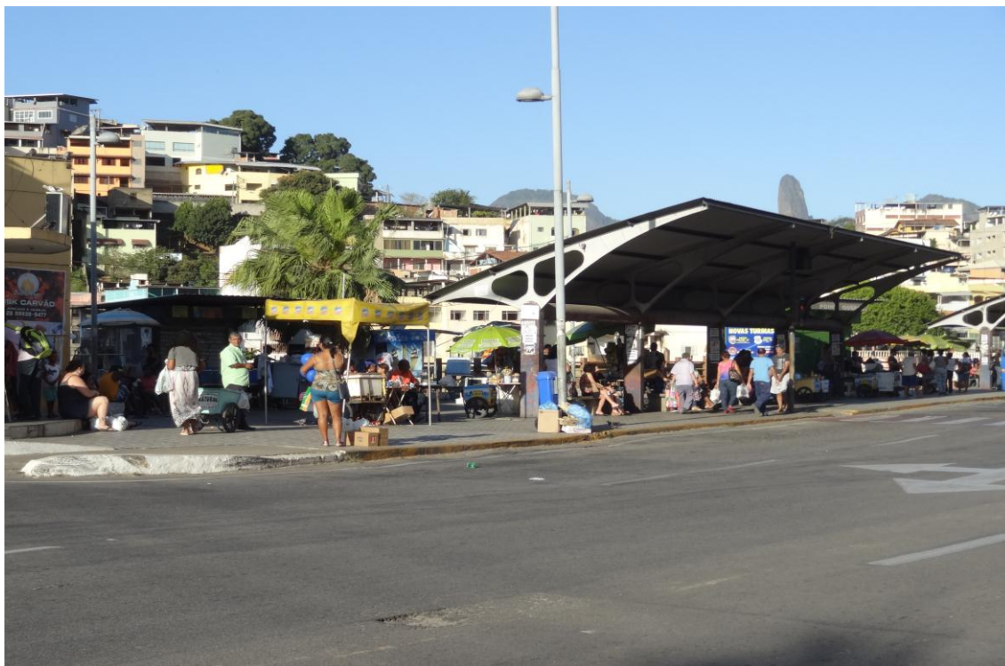
Fotografia 14 – Parada de ônibus da avenida Beira-Rio.
