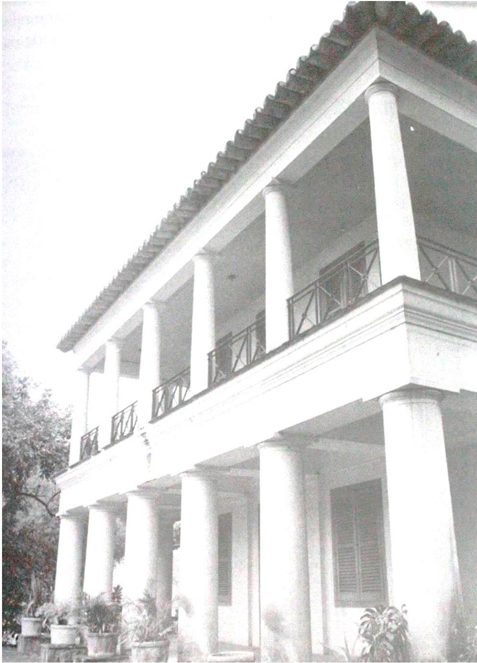
Imagem 43 – Frente da Casa de Grandjean de Montigny. 2000 157 .
