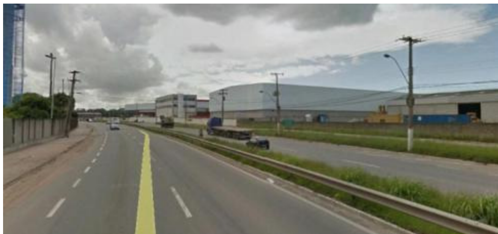
Figura 186: Rodovia Darly Santos, sentido Porto de Capuaba, anterior ao viaduto de cruzamento com a Av. Carlos Lindenberg.
