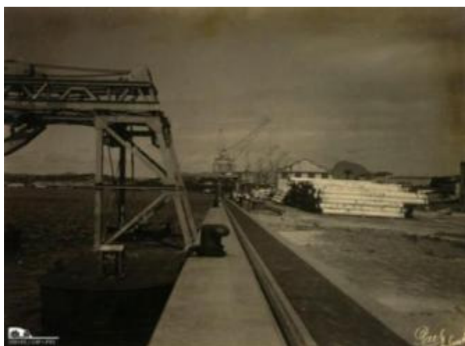
Figura 38: Plataforma em aterro com armazéns e equipamentos portuários, 1936.
