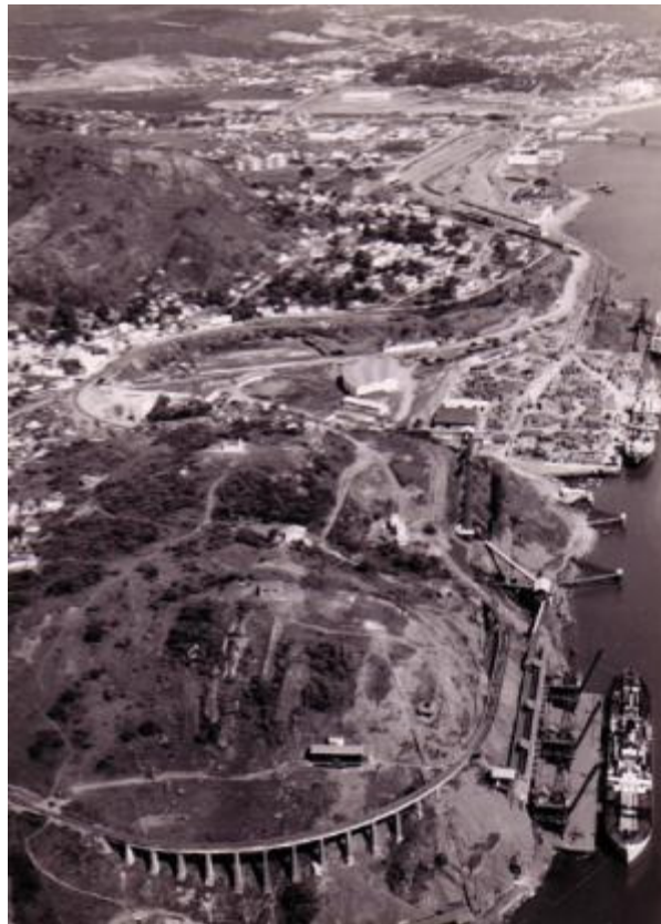
Figura 57: Vista dos Cais Eumenes Guimarães, com estruturas fixadas no Morro do Atalaia e o Cais de Paul, 1961. Observa-se que a instalação dos terminais consistiu na mudança significativa no sítio, seja por interferências nos elementos naturais perceptivos ou por obras de aterros.
