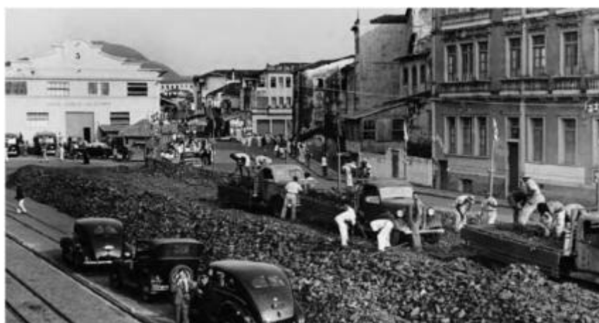
Figura 48: Minério de ferro descarregado no Porto de Vitória (ES), s/d. Observar a contiguidade física entre áreas portuárias e urbanas.
