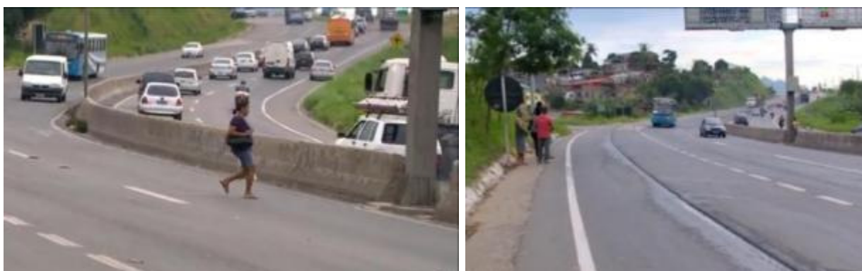
Figuras 213 e 214: Ausência de espaços de travessia de pedestres na Rodovia Contorno BR-101, nas imediações do Bairro Nova Rosa da Penha, em Cariacica.
