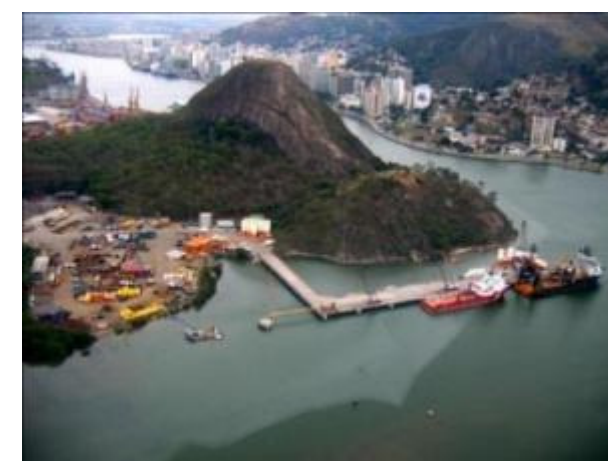
Figura 139: Implantação do CPVV contribui no comprometimento físico e visual do monumento, 2007.
