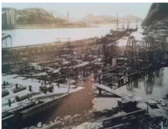
Figura 68: Obras de construção do Porto de Capuaba, sobre as águas, Vila Velha, década de 1970. Fonte: RIBEIRO (2008).
