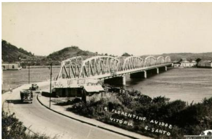
Figura 34: Ponte Florentino Avidos, 1940.
