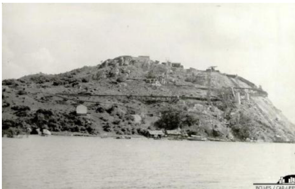
Figura 49: Início da construção do Cais Eumenes Guimarães no Morro do Atalaia, 1941.
