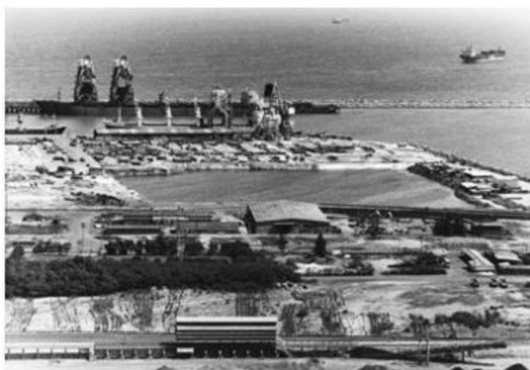
Figura 71: Obras no Terminal de Praia Mole.
