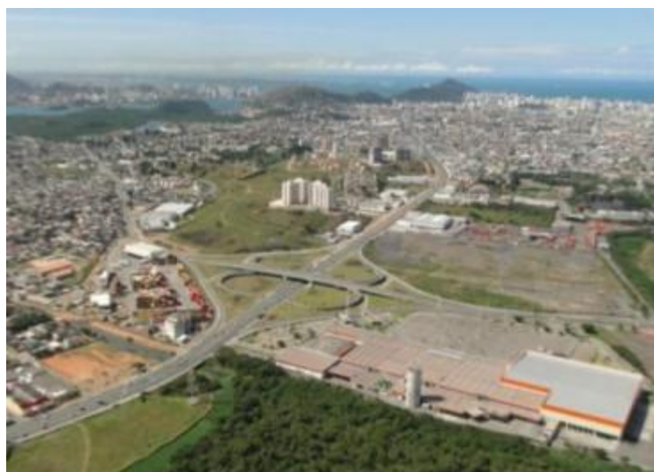
Figura 185: Vista aérea para viaduto entre a Av. Carlos Lindenberg (primeiro plano), Av. Capuaba (trecho ao fundo, à esquerda), e Rodovia Darly Santos (à direita).
