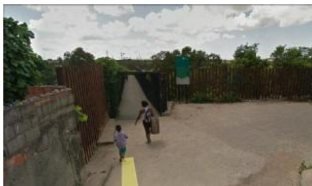
Figura 206: Passarela sobre a Ferrovia Vitória-Minas interligando os bairros Carapina e Central de Carapina, na Serra. Observar separação física entre a ferrovia e a área urbana.
