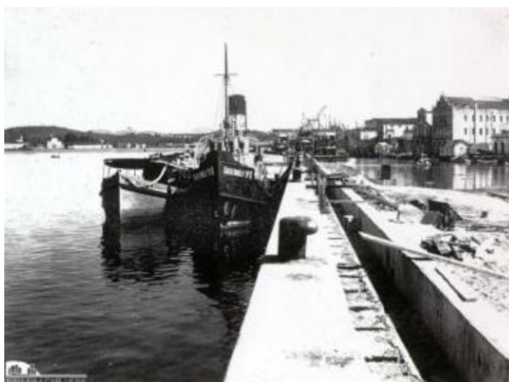
Figura 28: Enrocamento para a construção do Porto de Vitória, s/d.
