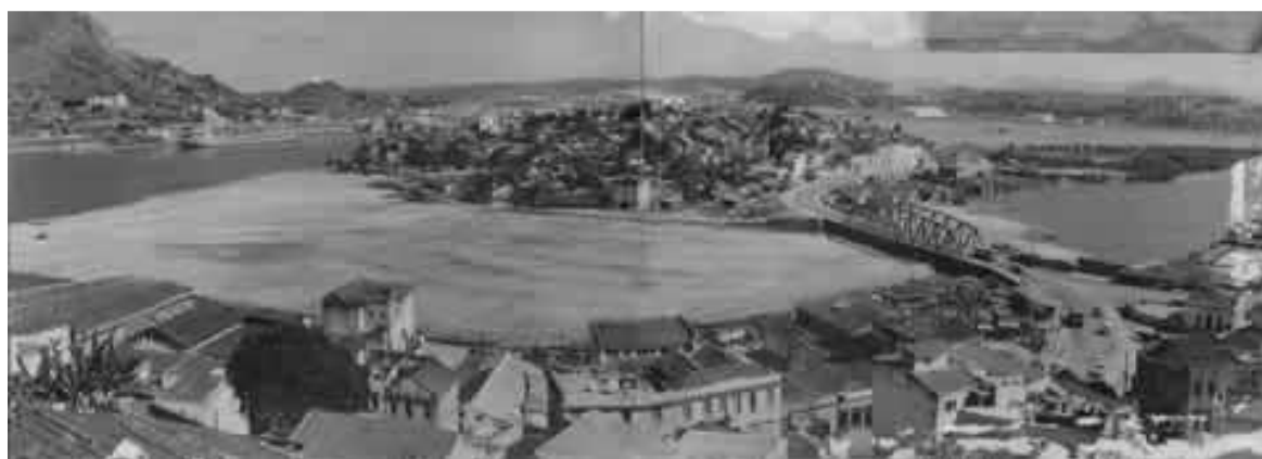
Figura 60: Aterro Ilha do Príncipe, década 1960. Observar a anexação da Ilha do Príncipe à Ilha de Vitória, o que desfaz a caracterização morfológica de ambas, em nome da expansão portuária. Destaca-se que uma das partes da Ponte Florentino Avidos, que fazia conexão da Ilha do Príncipe a Vitória, torna-se obsoleta, ficando conhecido como Ponte Seca.
