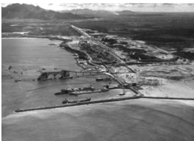
Figura 63: Vista aérea das obras de expansão do Terminal de Tubarão, entre 1971 e 1972.
