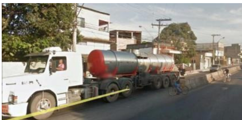
Figura 183: Ausência de espaços para pedestres e ciclistas na Av. Capuaba.
