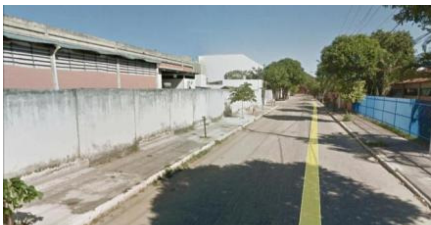
Figura 115: Vista para o Redex Flexibrás Tubos Flexíveis, (à esquerda da imagem).
