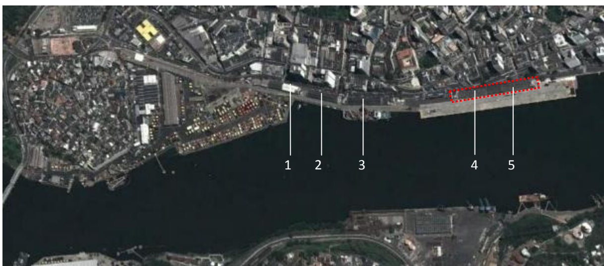
Figura 84: Imagem aérea do Cais Comercial de Vitória em 2014, com identificação dos armazéns portuários e demarcação (tracejado em vermelho) das possíveis estruturas a serem demolidas.
