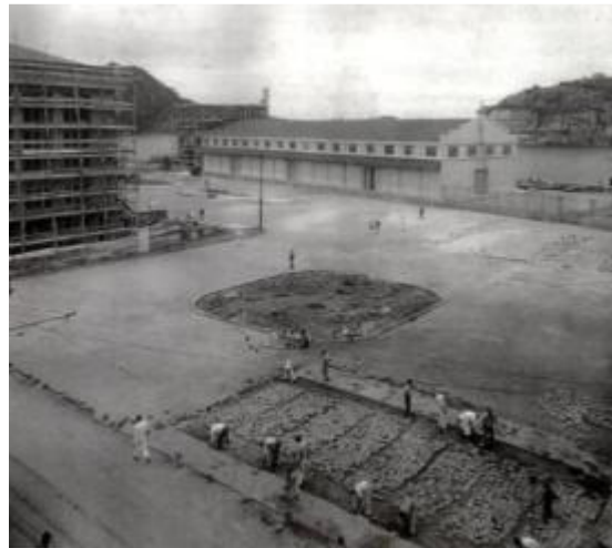
Figura 41: Construção da Praça Oito nas imediações do Cais Comercial, s/d. Fonte: MIRANDA (2001).
