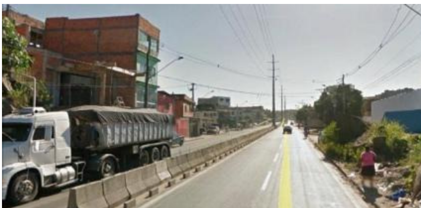
Figura 184: Ausência de calçadas na Av. Capuaba, eixo viário de baixa acessibilidade urbana.
