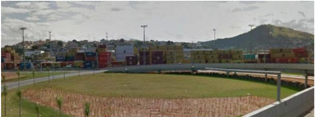
Figura 18: Terminal de contêineres da empresa MSC Mediterranean Logística, em Vila Velha (ES). Fonte: Google Earth Street View. Acesso em: 10 mar. 2014.
