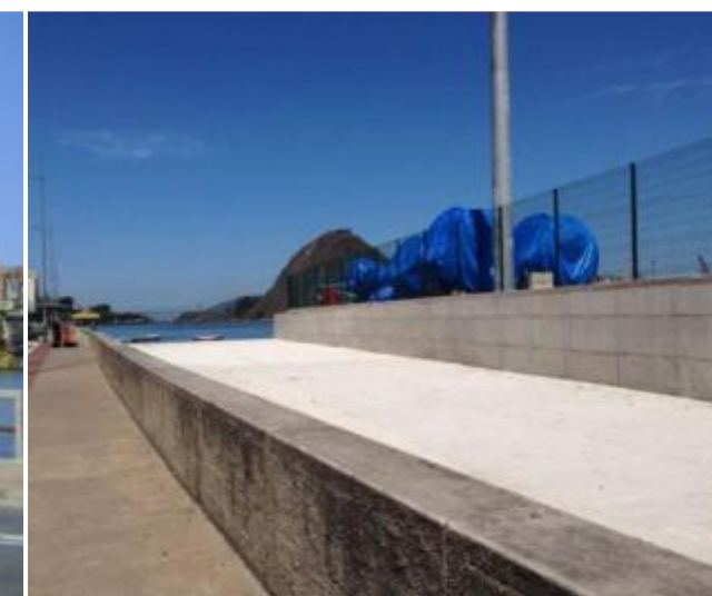
Figura 152: Vista para aterro do Cais Comercial do Porto de Vitória, (à direita da imagem), 2013. Observar que o muro e os gradis aumentam o comprometimento da percepção visual da Baía de Vitória.
