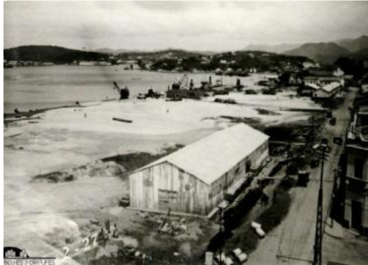
Figura 29: Obras de aterro no Porto de Vitória, 1927.
