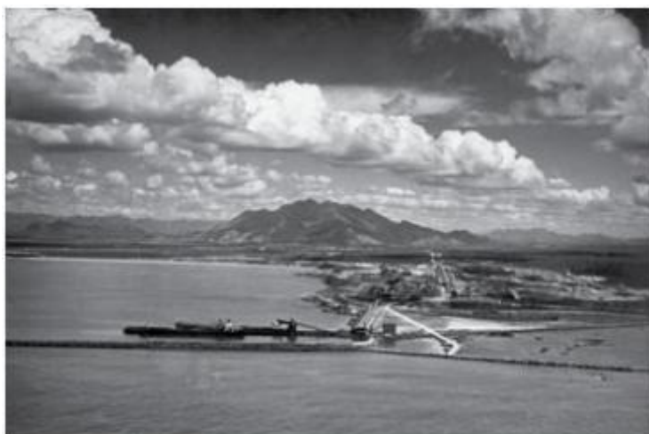
Figura 62: Vista da construção do Terminal de Tubarão, s/d. Observar a Praia de Camburi, à esquerda da imagem, predominantemente, sem ocupação urbana.
