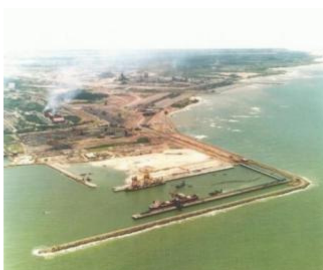
Figura 72: Obras no Porto de Praia Mole, década 1980.
