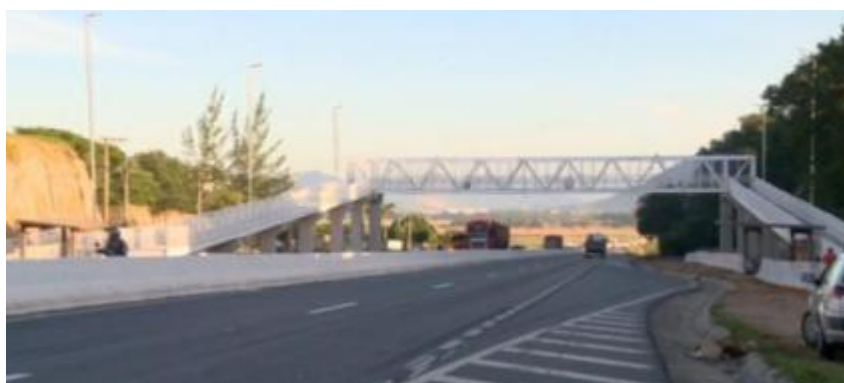
Figura 215: Passarela nas imediações bairro André Carloni, na Rodovia Contorno BR-101, Serra.
