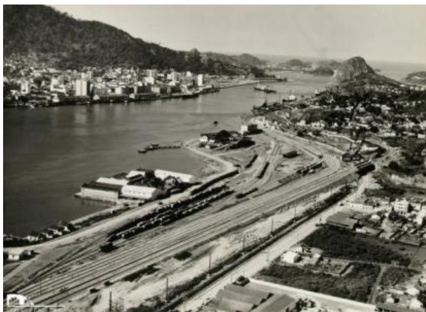
Figura 55: Obras para implantação dos terminais em Vila Velha, s/d. Fonte: MIRANDA (2001). Acervo: IJSN
