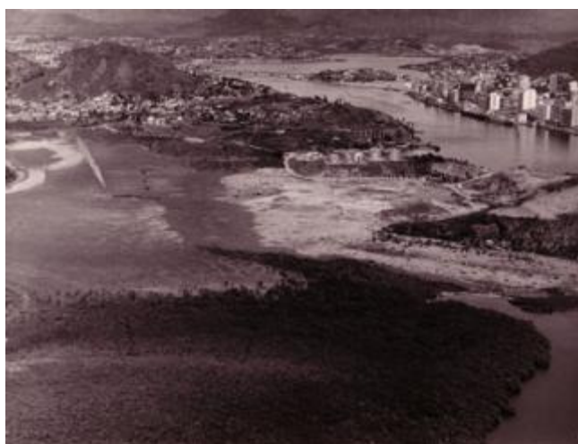
Figura 67: Vista anterior à construção do Porto de Capuaba. Observa-se parte do Rio Aribiri, com vegetação preservada, 1961.
