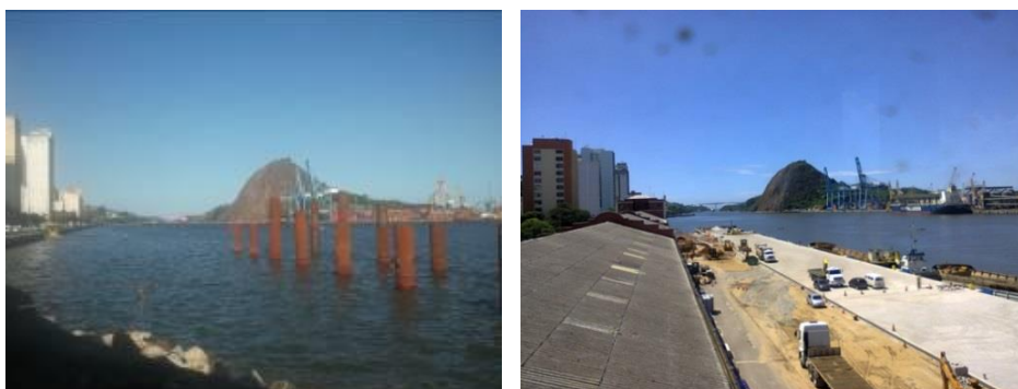
Figura 201 – Obra de ampliação do Cais de Vitória – 2012 e 2013.
