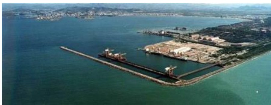
Figura 66 – Porto de Tubarão denotando o afastamento da cidade e do porto.
