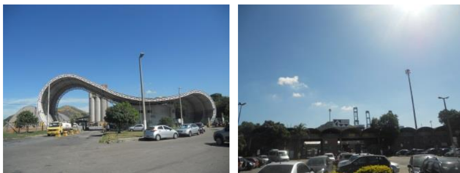
Figura 163 – Vista da Portaria do Porto de Capuaba, TVV e Nisibra.
