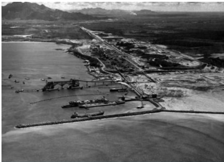
Figura 46 – Vista aérea das obras de expansão do Terminal Marítimo de Tubarão-ES entre 1971 e 1972.
