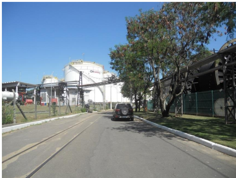
Figura 159 – A linha de ferro e as instalações de armazenamento de óleo – Oil Tanking.
