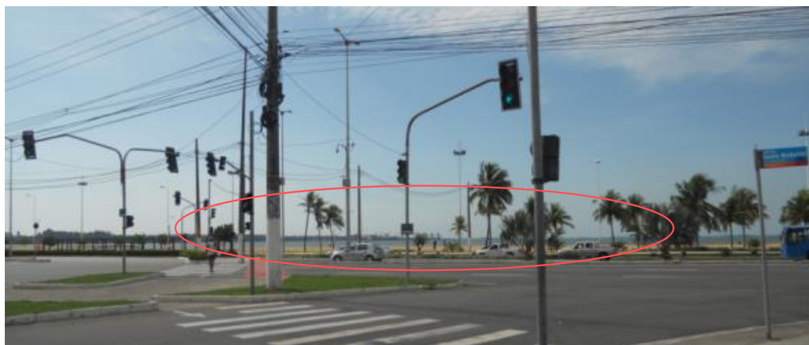
Figura 132 – Vista da esquina da Adalberto Simão Nader com Avenida Dante Micheline – um mar de fios e postes.
