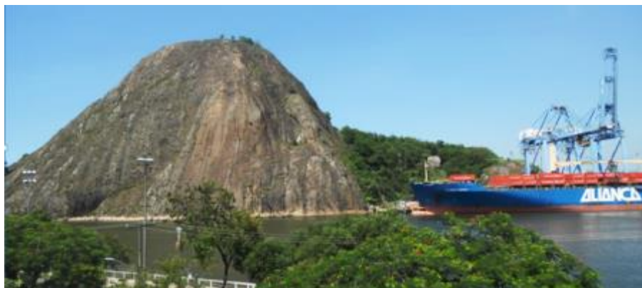
Figura 146 – Vistas do Penedo, da Baía e do Porto com navio atracado e seus guindastes azuis.
