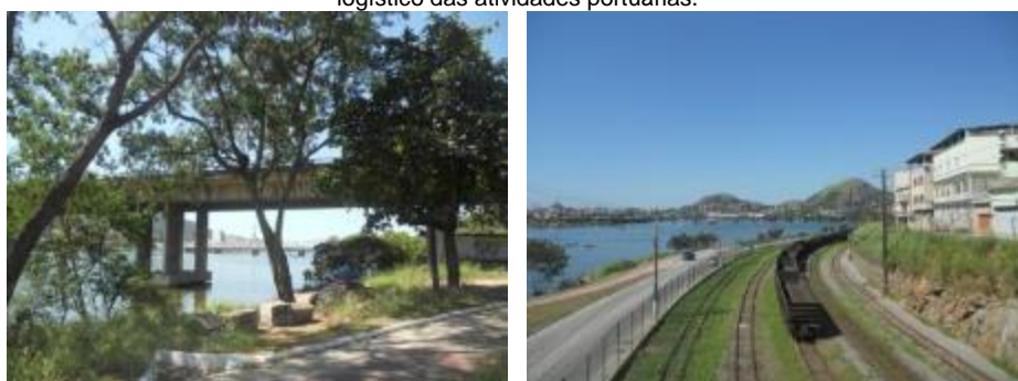
Figura 156 – Vistas do Porto de Vitória sob a Segunda Ponte e detalhe da linha férrea, representativa da estrutura de apoio logístico das atividades portuárias.
