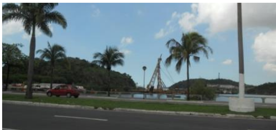
Figura 145 – Vista da Ilha da Fumaça, com instalações de estaleiros.
