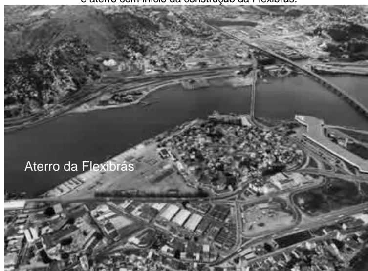
Figura 51 – Foto aérea da área da Vila Rubim, década de 1980, destacando a Ilha do Príncipe e aterro com início da construção da Flexibrás.
