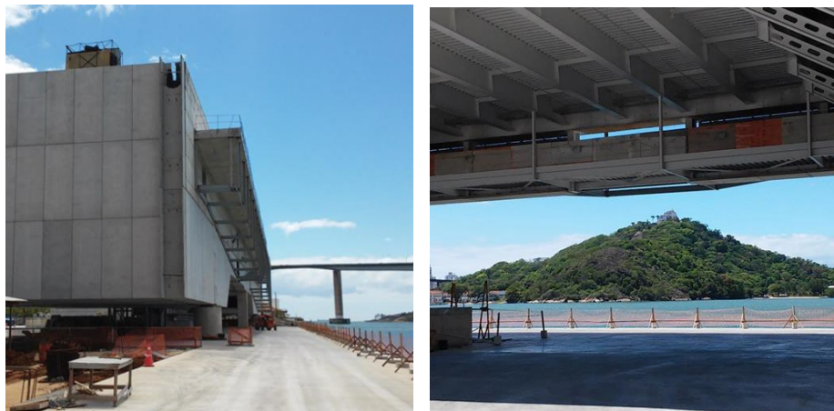
Figura 196 – Imagens da obra do Cais das Artes, na Enseada do Suá, em andamento.
