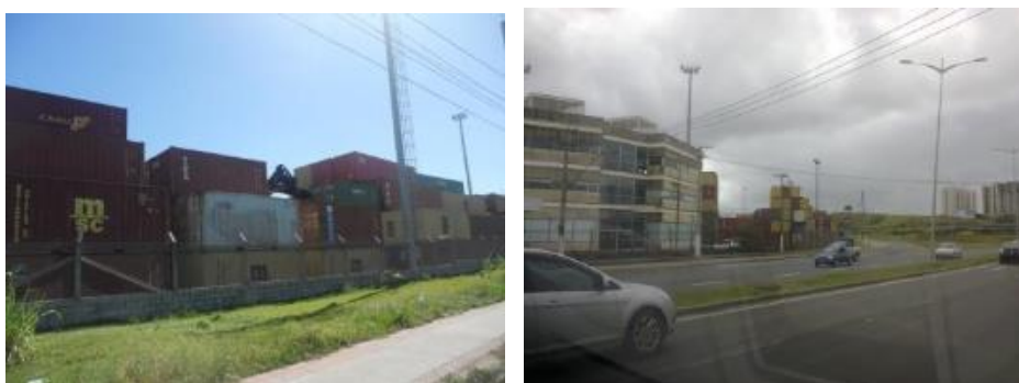
Figura 111 – Edifícios contêineres na Avenida Carlos Lindenberg e Estrada de Capuaba na Darly Santos.
