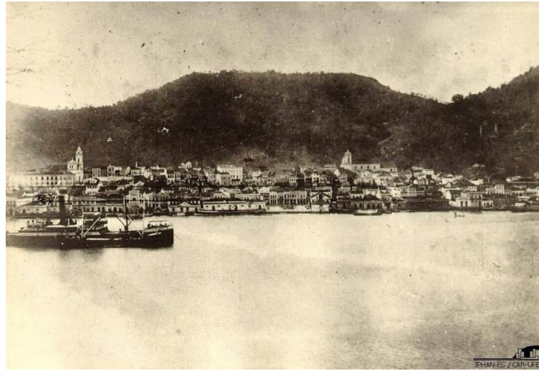
Figura 21 – Porto de Vitória - 1909: vista panorâmica da cidade de Vitória com o Maciço Central ao fundo.
