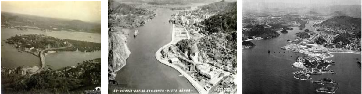
Figura 36 – Sequência de fotos de aterros em Vitória: Ilha do Príncipe (1936), aterro da Capixaba (1960), aterro da Enseada do Suá e início da construção da Terceira Ponte (1980).
