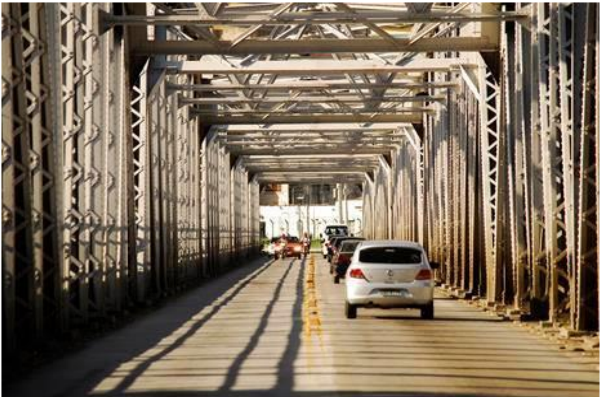
Figura 23 - Cinco Pontes com realce para sua estrutura metálica treliçada.
