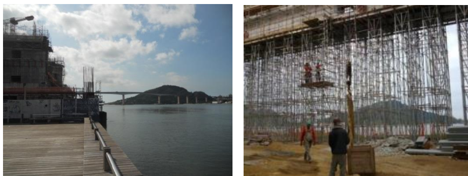
Figura 140 – Vista do deck da Praça do Papa e do Convento da Penha a partir do Cais das Artes, em construção.
