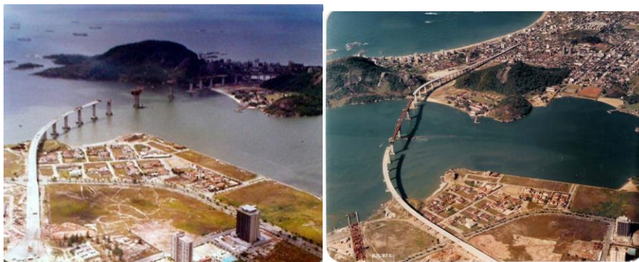
Figura 52 – Vistas da Terceira Ponte em construção na década de 1980.
