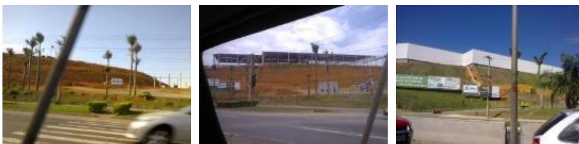
Figura 107 – Polo logístico em Viana, em início de obras (2013) e em implantação (2014).
