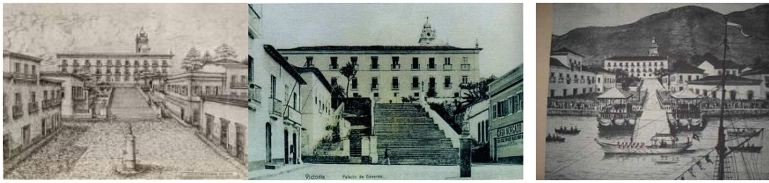
Figura 12 – Antigo Cais das Colunas / Cais do Imperador (1860); Escadaria do Palácio do Governo (final do século XIX) e Cais das Colunas, preparado para receber ilustres visitantes.
