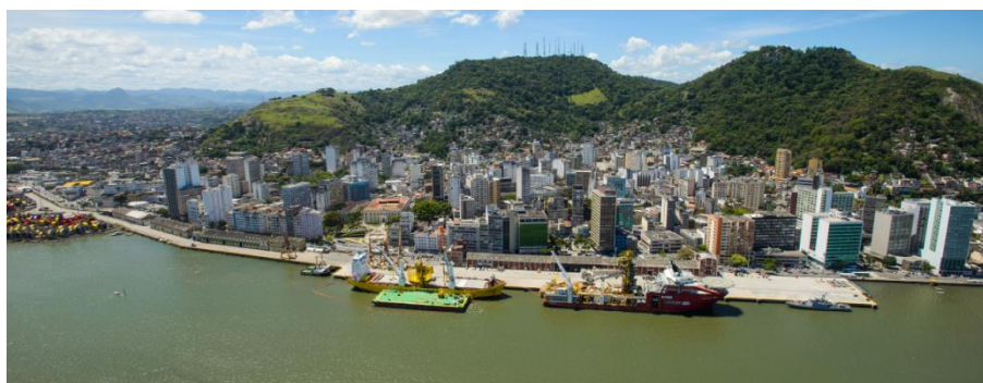
Figura 202 – Cais de Vitória com as obras de ampliação terminadas em 2014.
