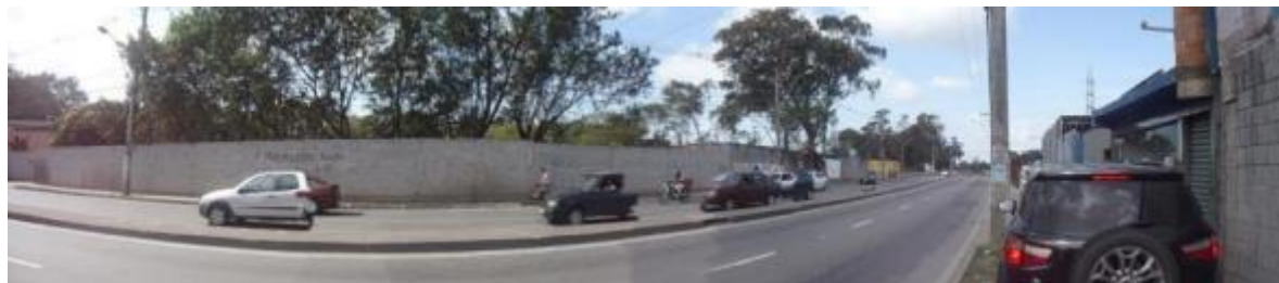
Figura 121 – Vista dos muros-limite da Vale.
