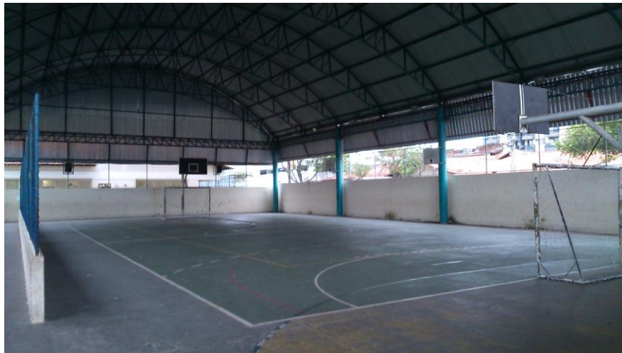
Foto 11a: Quadra coberta. Fonte: Arquivo pessoal.
