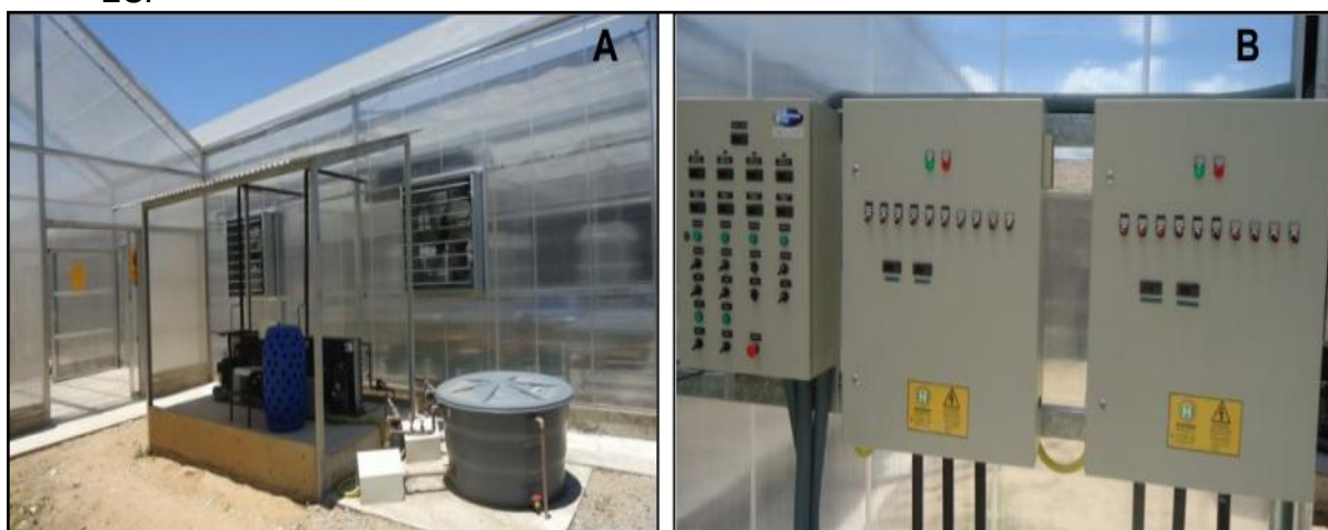
Figura 1: Estrutura externa da casa de vegetação climatizada (A) e painel de controle das variáveis climáticas da casa de vegetação (B), no município de Jerônimo Monteiro, ES.
