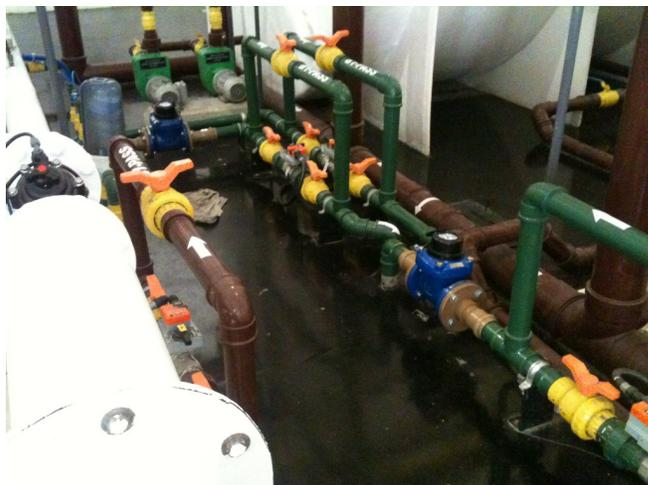
FIGURA 6 - HIDRÔMETROS USADOS NO MONITORAMENTO DO CONSUMO DE ÁGUA INSTALADOS NA ETE+R PARA MEDIÇÃO DO VOLUME DE ÁGUA DE REÚSO.
