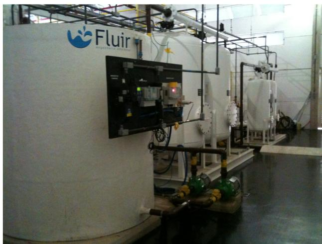
FIGURA 5 - ETE+R COM DESTAQUE PARA OS MEDIDORES DE TURBIDEZ, PH E CLORO RESIDUAL INSTALADOS NA LINHA DE PRODUÇÃO DE ÁGUA DE REÚSO PARA IRRIGAÇÃO E BACIAS SANITÁRIAS E AO LADO OS DOIS CONJUNTOS DE FILTROS DE CARVÃO ATIVADO E AREIA.
