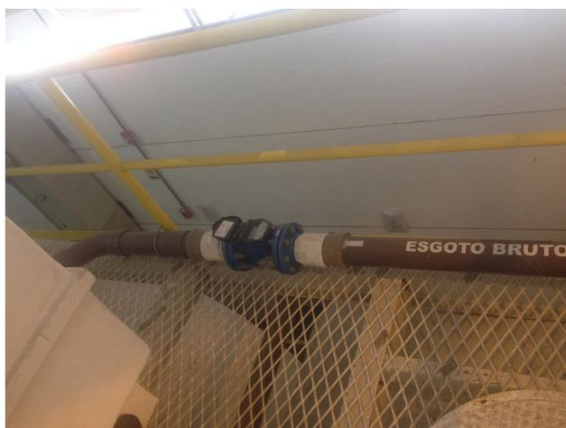
FIGURA 7 - HIDRÔMETRO USADO PARA MONITORAMENTO DO VOLUME DE ESGOTO SANITÁRIO PRODUZIDO NA EDIFICAÇÃO.
