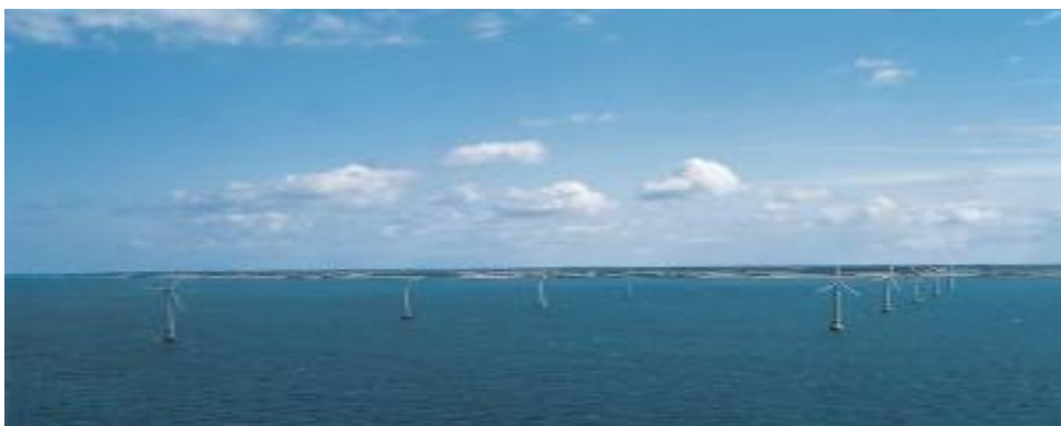
Figura 23 - Primeiro parque eólico offshore do mundo, em Vinderby na Dinamarca
