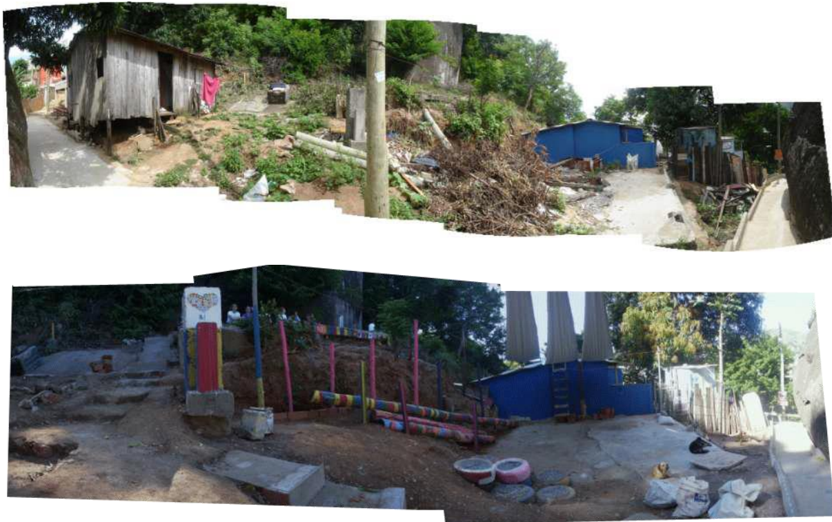
Figura 19 - Conjunto de fotos do antes e depois da intervenção Mutirão do Bem na comunidade de Jaburu.
