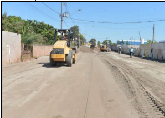
Fotografia 26 - Ampliação da ES-388 (obras iniciadas)
