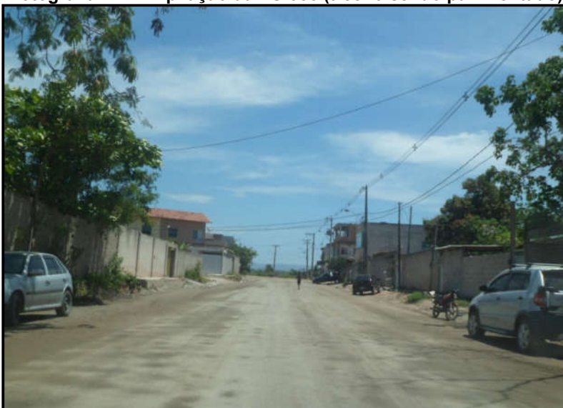
Fotografia 27 - Ampliação da ES-388 (trecho sendo pavimentado)
