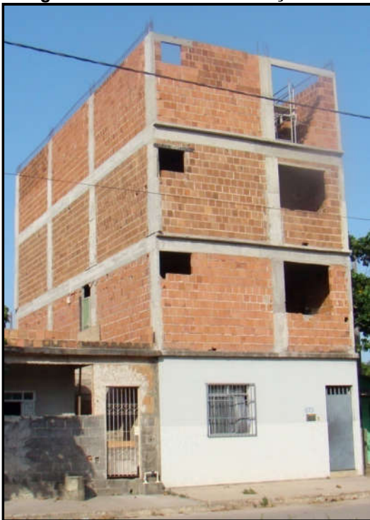
Fotografia 9 - Imóvel em construção
