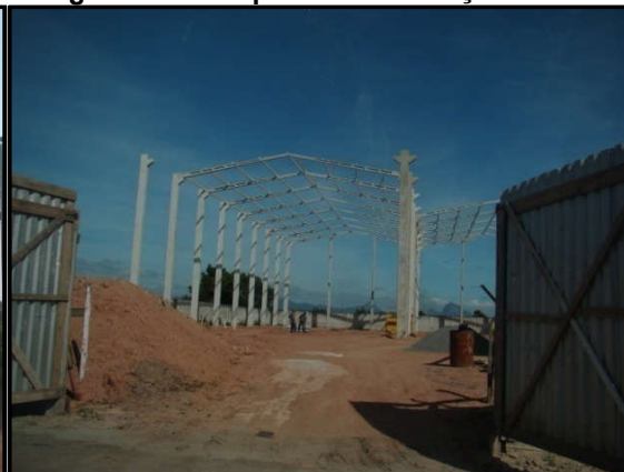
Fotografia 31 - Galpão em construção
