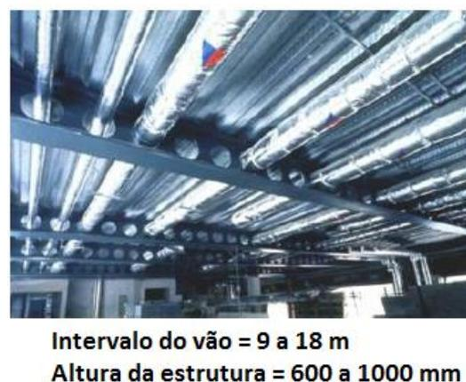
Figura 11 - Vigas celulares de aço e vigas celulares mistas de aço e concreto
