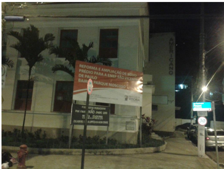
Imagem 1: Vista externa do prédio Polo Americano
