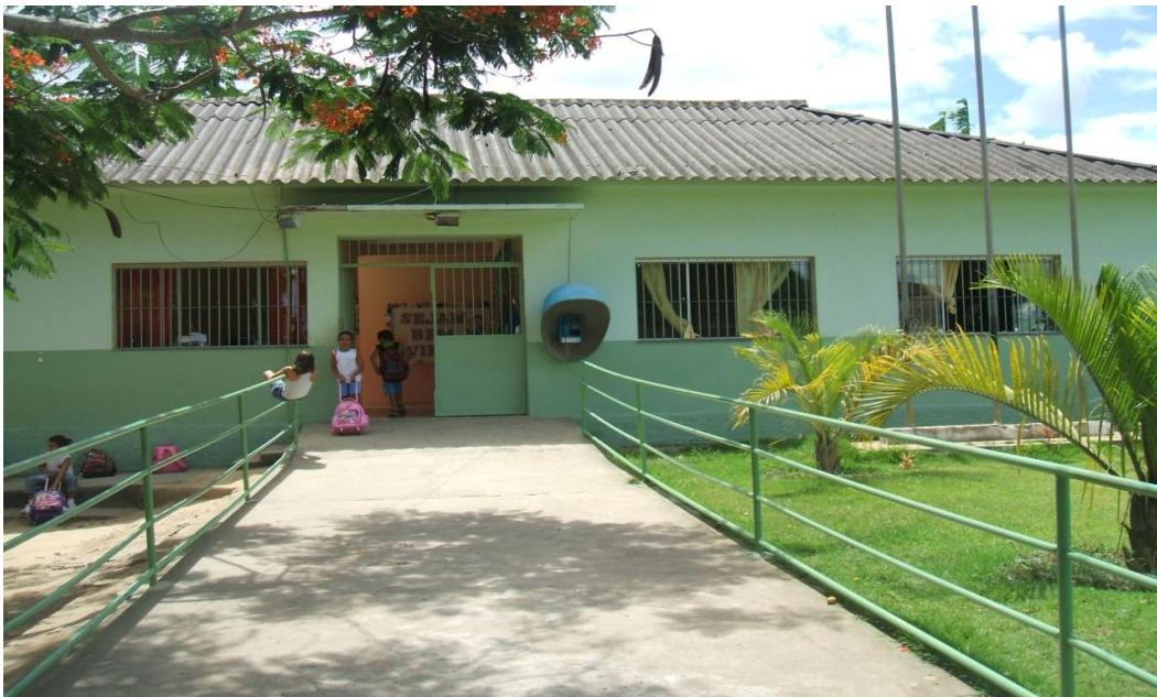
Imagem 3: Vista externa da EMEF São José do Jundiá
