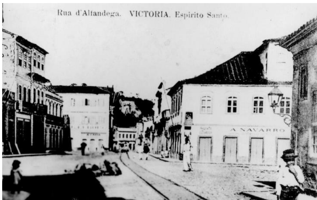
Figura 19: Trecho da Rua da Alfandega (1908).
