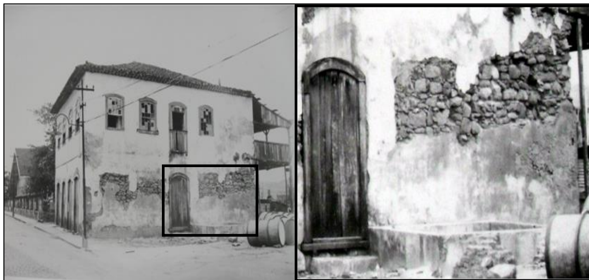
Figura 8: Casarão na Rua da Alfândega.
