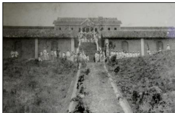
Figura 11: Hospedaria, vista da entrada.
