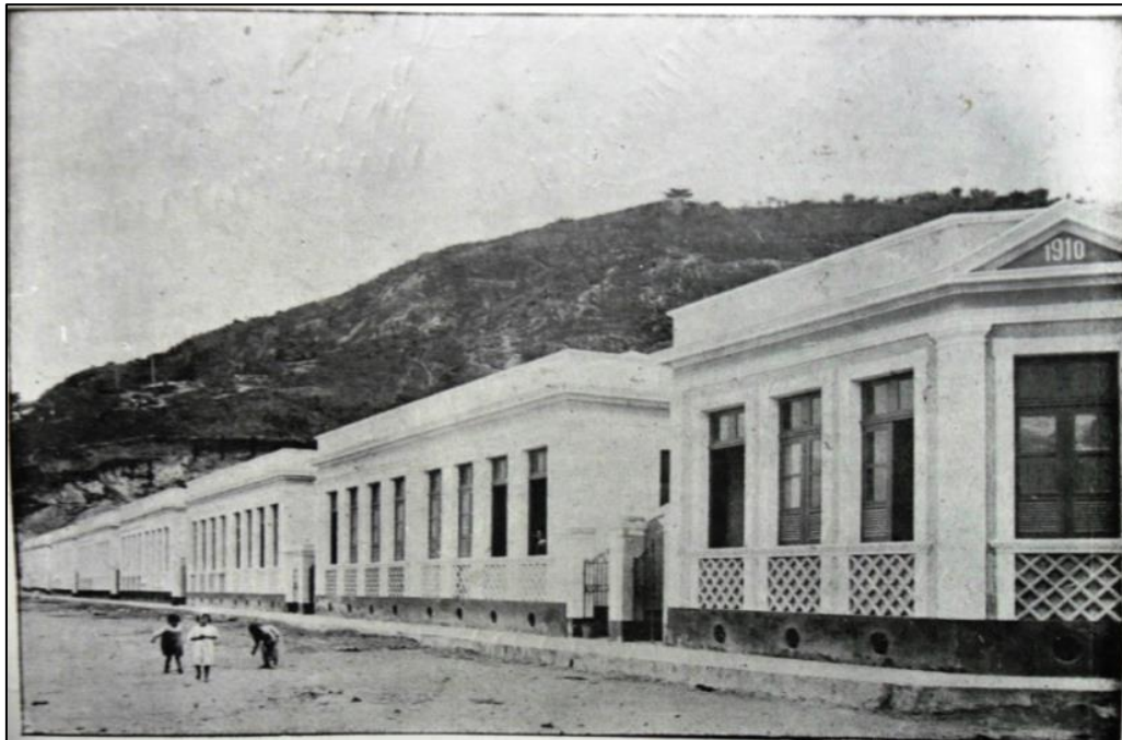
Figura 24: Residências construídas para os funcionários públicos no Campinho (1911).
