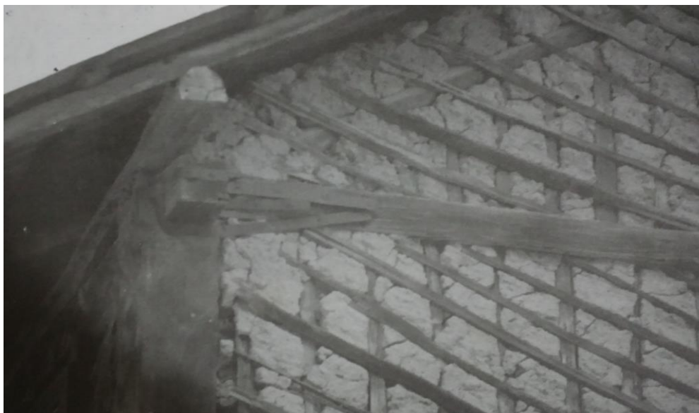
Figura 13- Fotografia mostrando detalhe da Casa Lambert que destaca armação de taipa no sentido diagonal.
