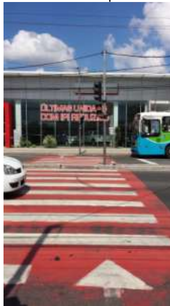
Figura 36: NSP-01 com canteiro pavimentado em concreto
