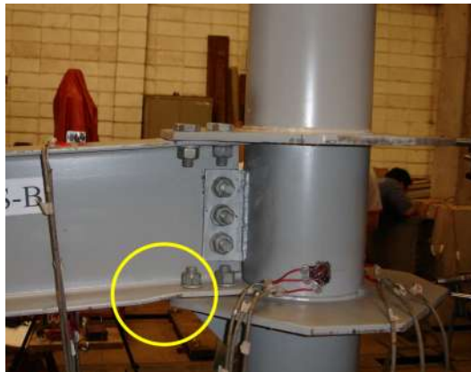
Figura 2.17: Deformação da mesa inferior da viga para ligação com diafragma externo
