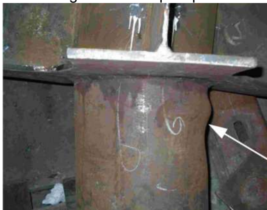
Figura 2.16: Região da flambagem local no pilar para os três modelos ensaiados
