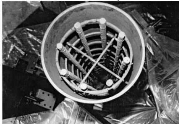
Figura 2.5: Pilar tubular circular a ser preenchido com concreto
