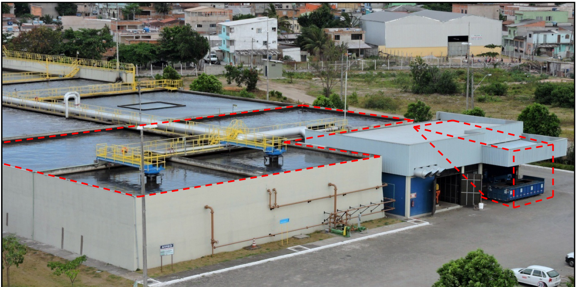
Figura 53 – Polígono a esquerda delimita o digester e adensadores de lodo, enquanto o polígono a direita representa o galpão de centrifugação e a caçamba de armazenamento de lodo úmido.
