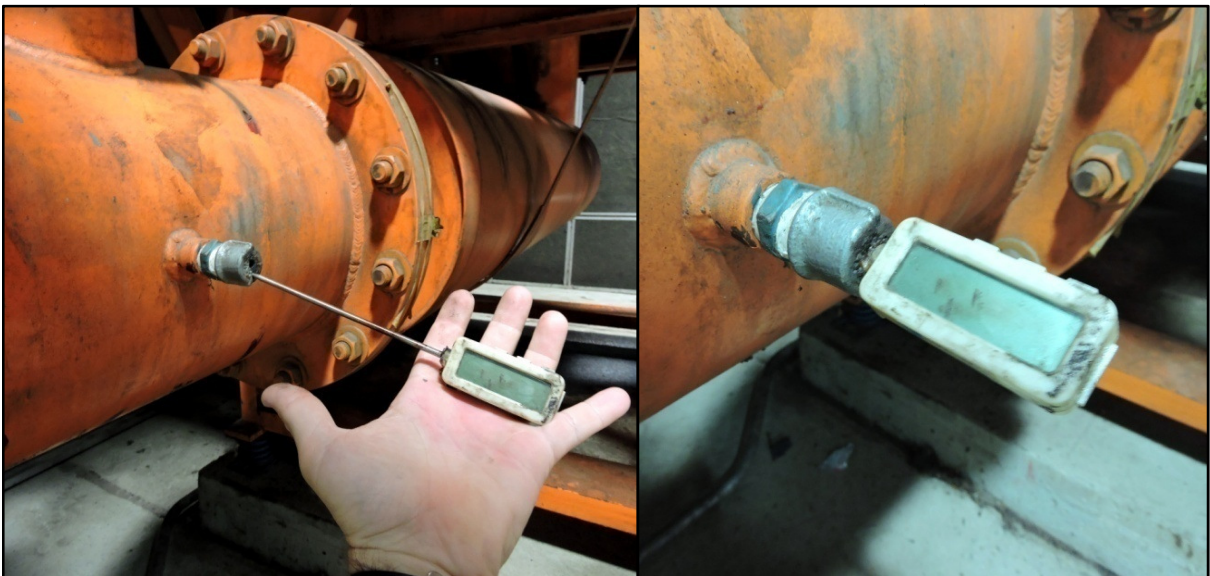
Figura 32 – Detalhe da adaptação do termômetro na descarga do soprador de ar.
