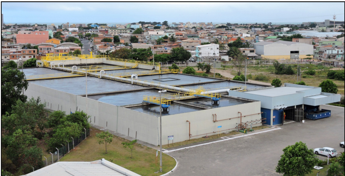
Figura 26 – Vista aérea da ETE Araçás, Vila Velha/ES, ano de 2015.
