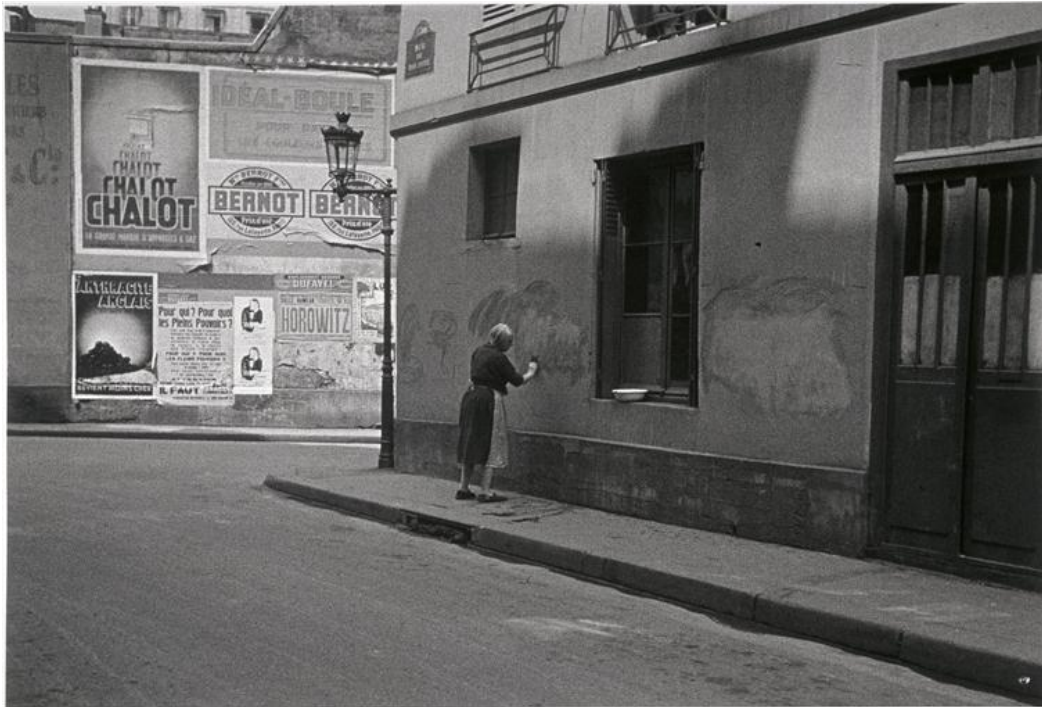
Figura 172 - FREUND, Gisèle. Nettoyage de la façade. Paris, 1935
