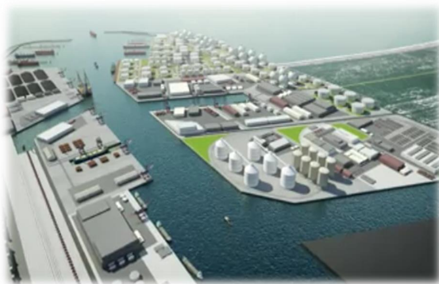
Imagem 9: Projeto da estrutura portuária para transporte e armazenamento do setor petrolífero na região litorânea Sul Capixaba. / Fonte: Assembléia Legislativa do ES.
