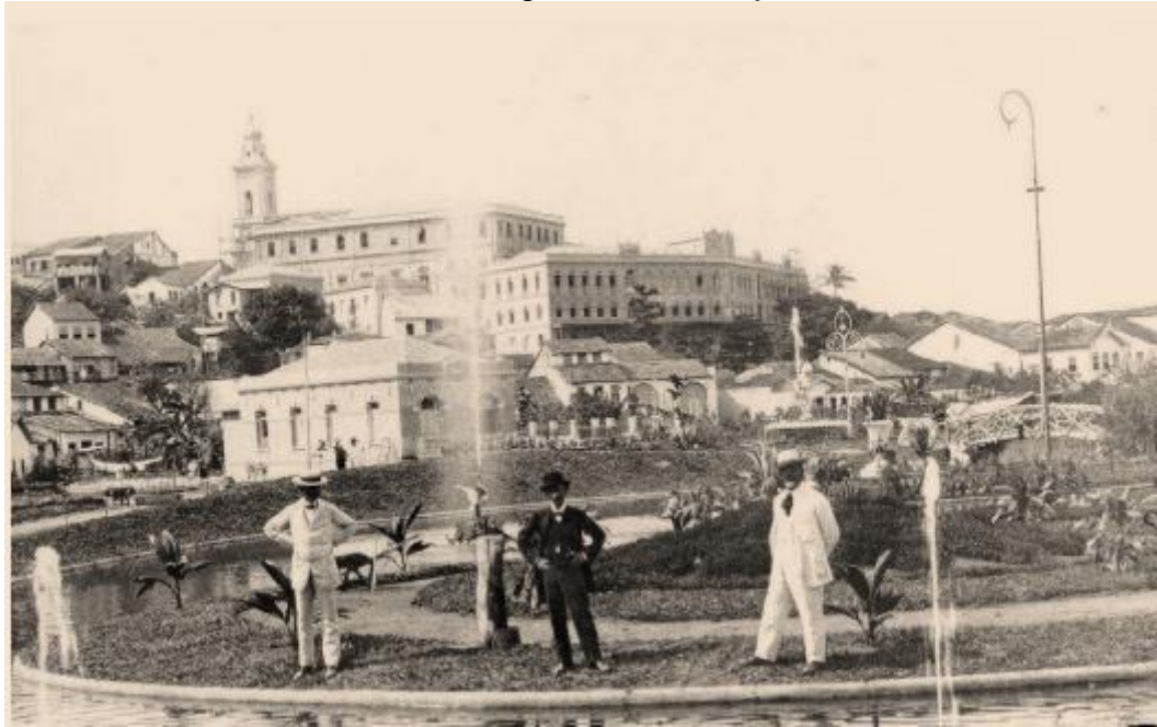
Figura 14 – Campinho ou Praça Moscoso em maio de 1912, depois de concluídos os trabalhos de drenagem, aterro e ajardinamento
