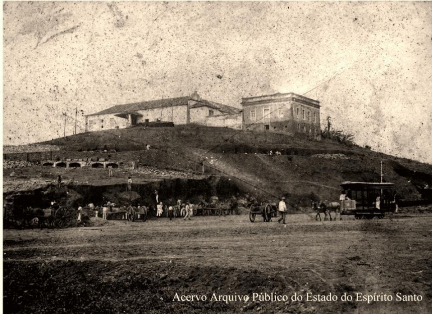
Figura 24 – Santa Casa de Misericórdia, antes e depois da construção
