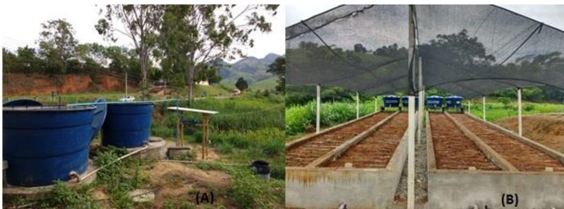
Figura 3 – Unidade piloto de tratamento de água residuária, reservatórios de 5.000 L e filtro orgânico (A) e rampas de tratamento e reservatórios de 500 L (B).
