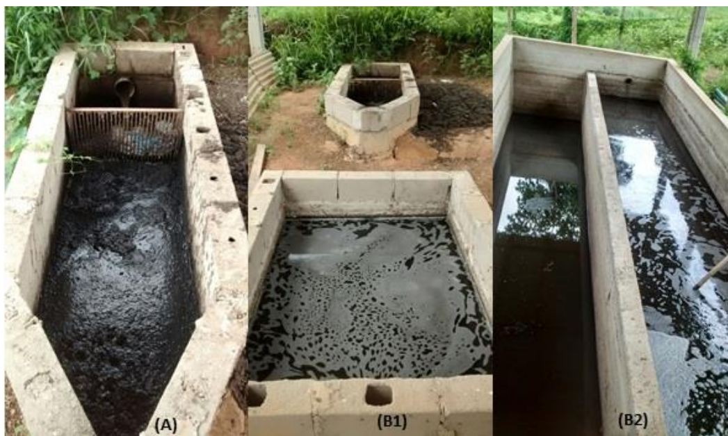
Figura 2 – Sistema preliminar de tratamento da água residuária de suinocultura da criação de suínos do CCAE/UFES, sistema de gradeamento (A) e esterqueiras (B1 e B2).
