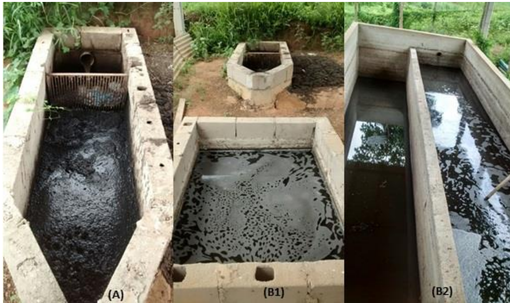
Figura 2 – Sistema preliminar de tratamento da água residuária de suinocultura da criação de suínos do CCAE/UFES, sistema de gradeamento (A) e esterqueiras (B1 e B2).
