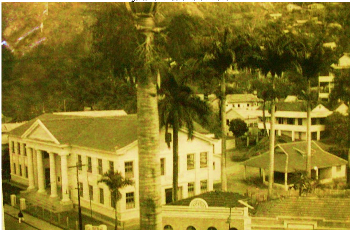
Figura 10- Prédio Loren Reno
