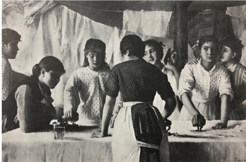
Figura 7 – Oficina de passadeiras
