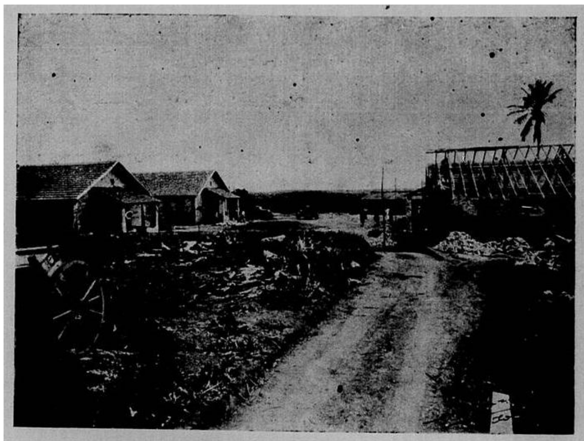
Figura 15 – Obras iniciais da Colônia de Itanhenga: avenida e pavilhões em 1934
