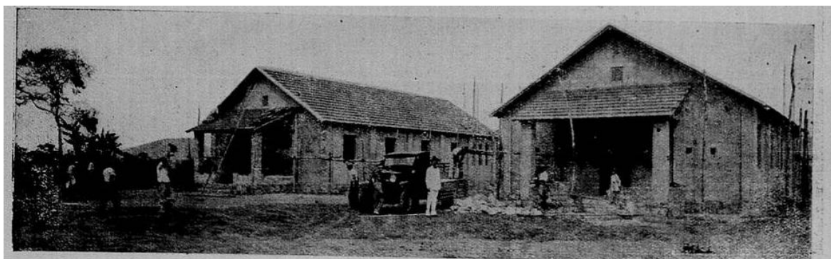
Figura 14 – Obras iniciais da Colônia de Itanhenga: pavilhões em 1934
