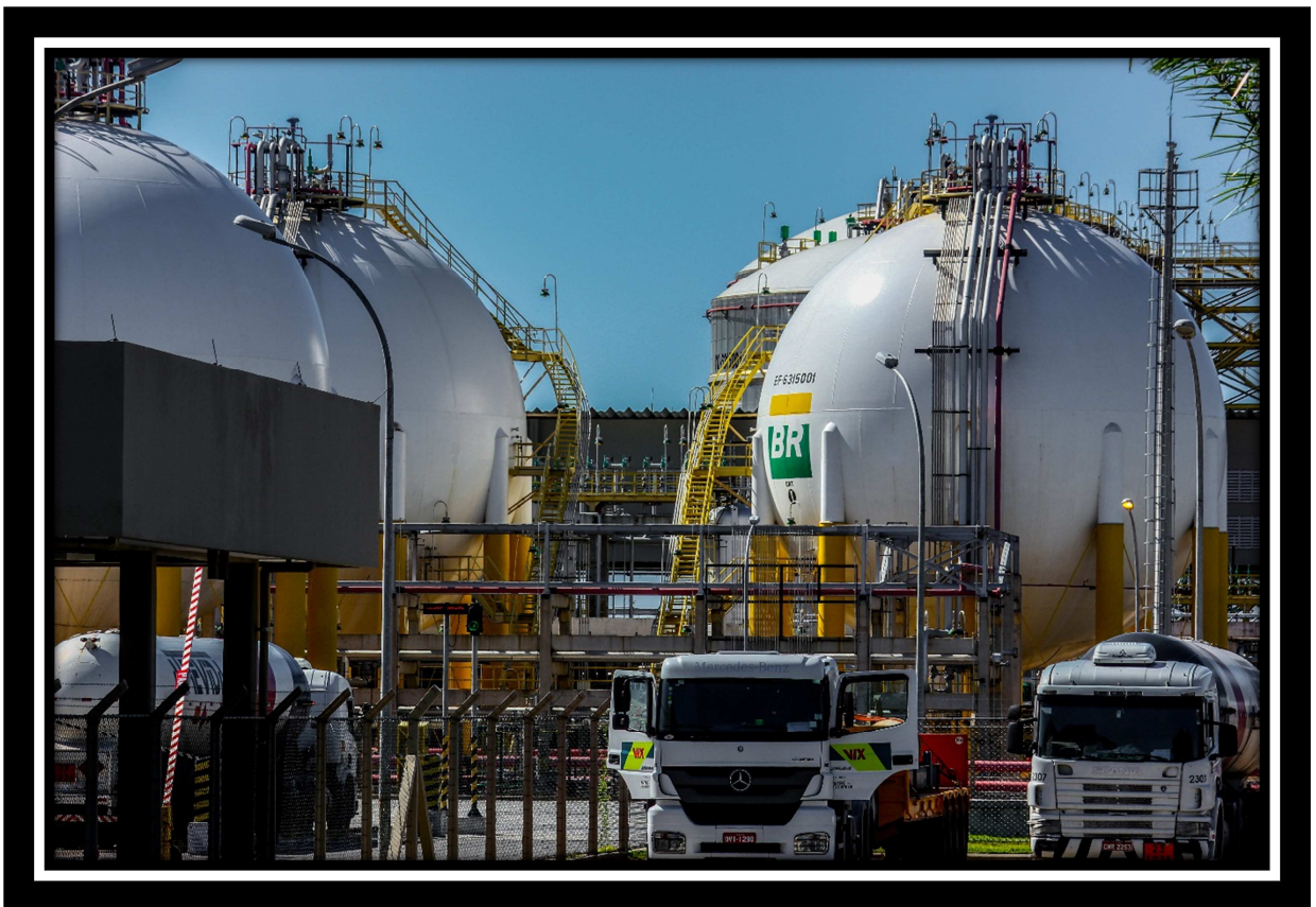
Figura 10 - Terminal de Abastecimento da Petrobras em detalhes.
