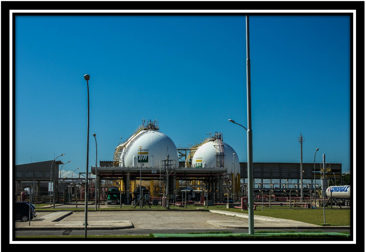
Figura 9 - Terminal de Abastecimento da Petrobras (TABR)
