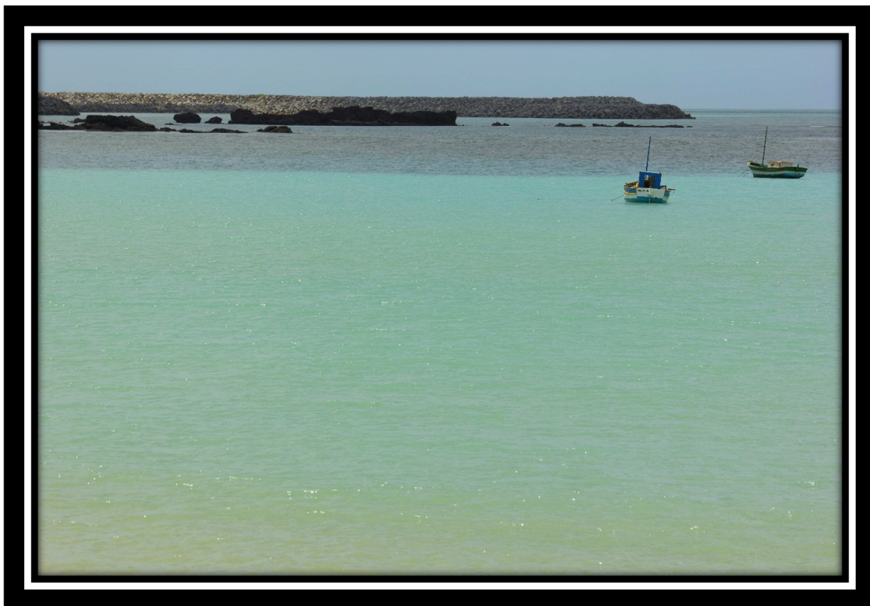
Figura 57 - Barcos aportados ao sul do Estaleiro Jurong Aracruz. Ao fundo o píer do estaleiro de aproximadamente 3 km.
