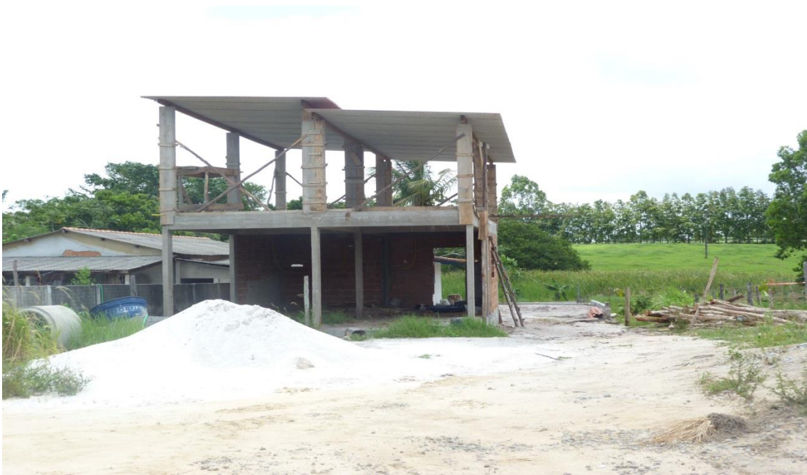
Figura 9, Casa em construção em Baixo Quartel
